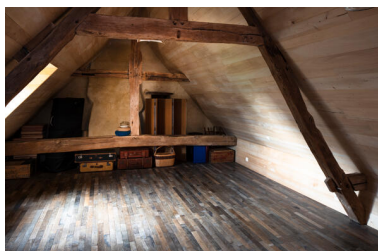
Logis : charpente. Phot. Thierry Seldubuisson IVR52_20247200365NUCA
