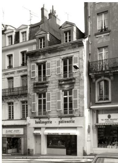
Elévation antérieure. Phot. François Lasa IVR52_19894901066V
