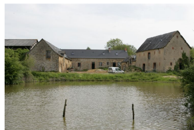
Vue d'ensemble depuis le sud- ouest : l'étable à vaches, le logis- étable, l'étable à chevaux-porcherie. Phot. François Lasa IVR52_20055301471NUCA
