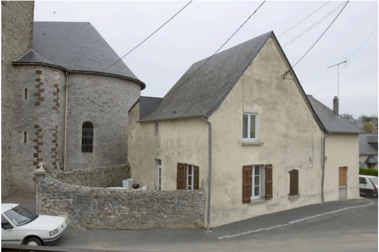
Vue depuis le sud-ouest.
