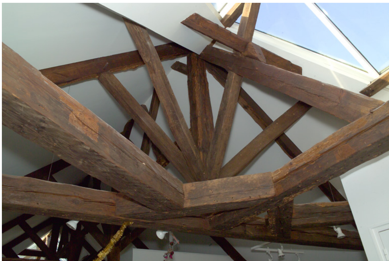
Comble, détail de la charpente.
