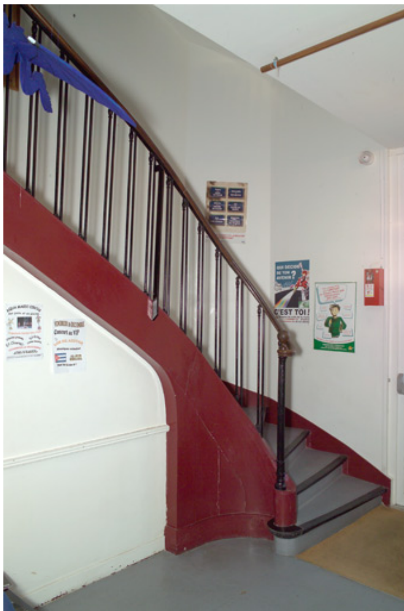
Départ de l'escalier, rez-de-chaussée.
