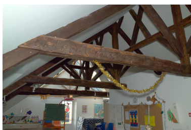
Comble, détail de la charpente. Phot. Denis Pillet IVR52_20054402266NUCA
