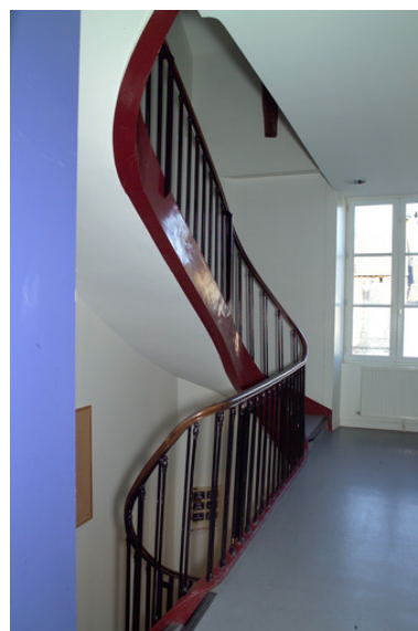
Escalier, premier étage. Phot. Denis Pillet IVR52_20054402269NUCA
