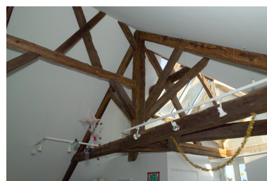
Comble, détail de la charpente. Phot. Denis Pillet IVR52_20054402264NUCA
