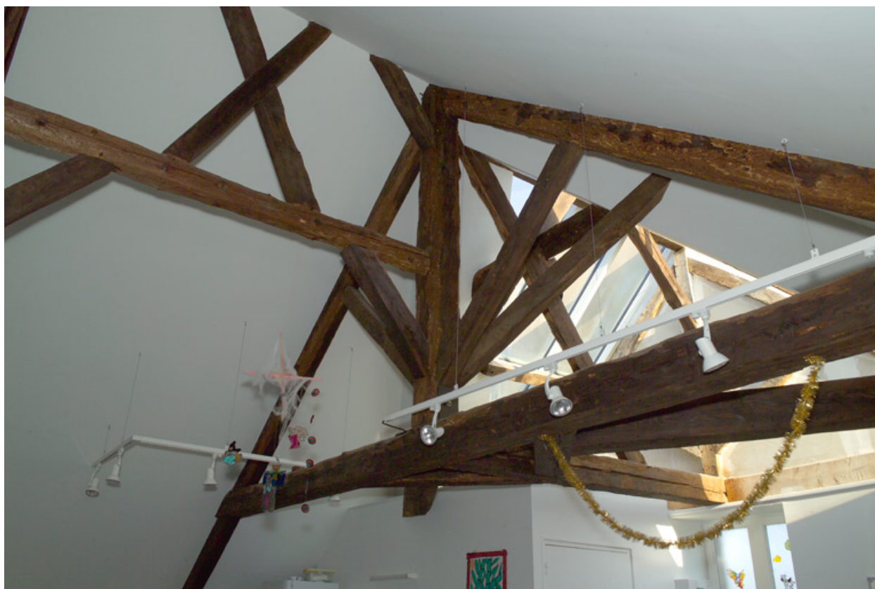
Comble, détail de la charpente.
