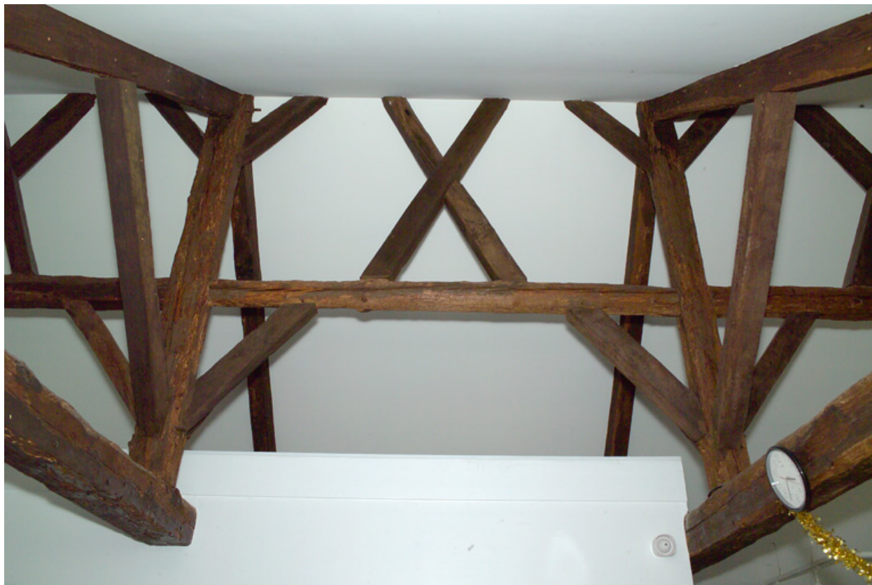
Comble, détail de charpente.
