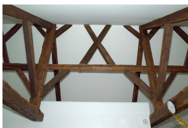
Comble, détail de charpente. Phot. Denis Pillet IVR52_20054402263NUCA
