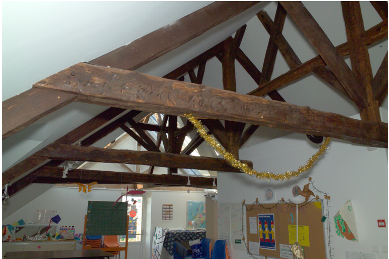
Comble, détail de la charpente.
