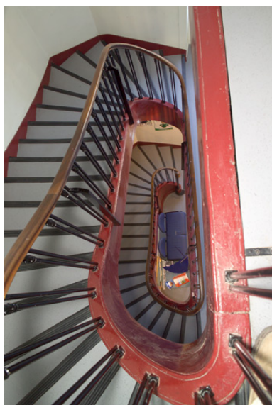
Escalier vu du comble. Phot. Denis Pillet IVR52_20054402268NUCA
