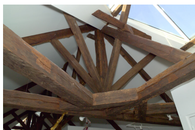
Comble, détail de la charpente. Phot. Denis Pillet IVR52_20054402265NUCA
