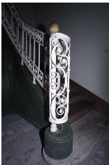
Le départ de l'escalier. Phot. Denis Pillet IVR52_20034401529NUCA
