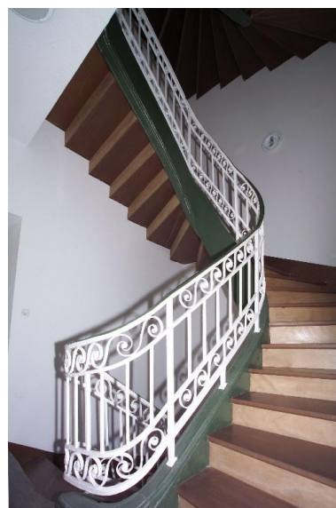
La seconde volée de l'escalier. Phot. Denis Pillet IVR52_20034401528NUCA
