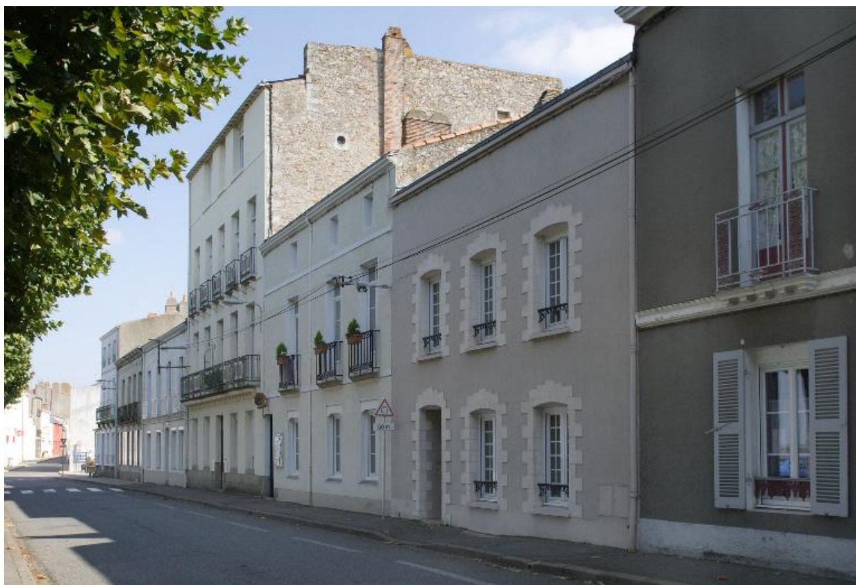
La façade sur le quai.
