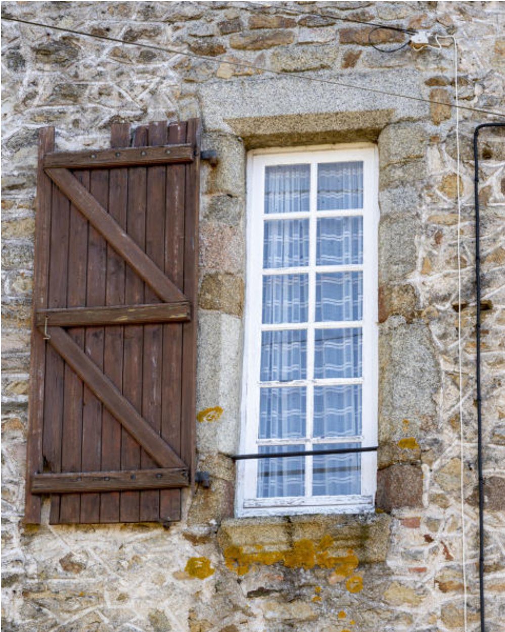
L'ancien logis du prieur, une fenêtre à appui mouluré.
