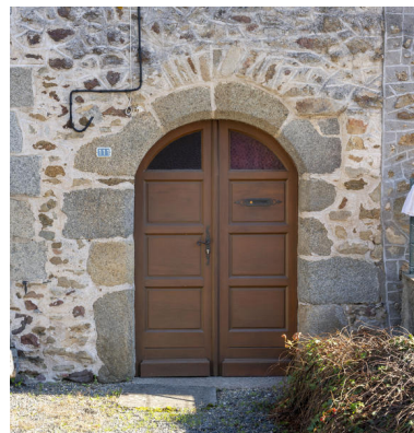
L'ancien logis du prieur, la porte. Phot. Pierre-Bernard Fourny IVR52_20215301706NUCA
