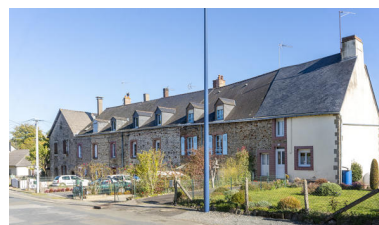
Le corps de bâtiment subsistant. Phot. Pierre-Bernard Fourny IVR52_20215301708NUCA
