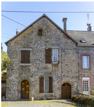
L'ancien logis du prieur. Phot. Pierre-Bernard Fourny IVR52_20215301705NUCA
