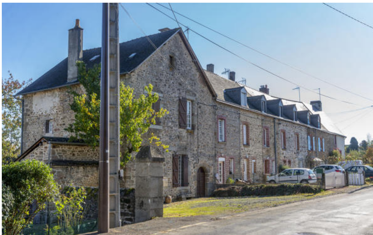
Le corps de bâtiment subsistant.
