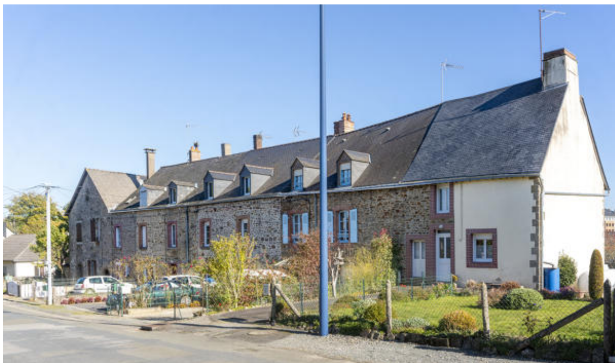
Le corps de bâtiment subsistant.
