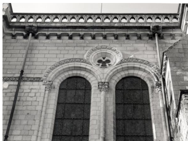
Travée droite du chœur, élévation extérieure nord : partie supérieure de la baie géminée. Phot. François Lasa IVR52_20014901845X
