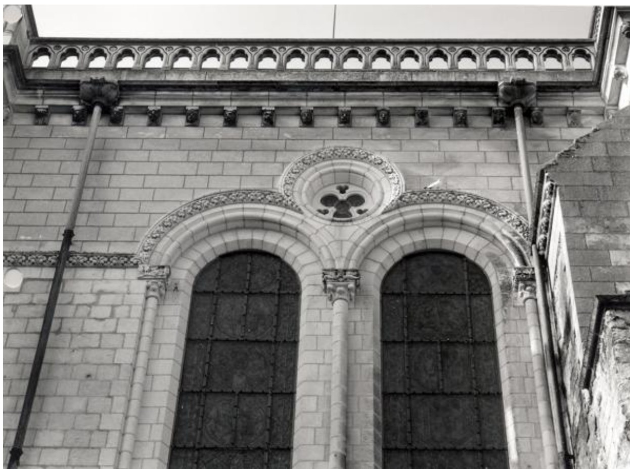
Travée droite du choeur, élévation extérieure nord : partie supérieure de la baie géminée.
