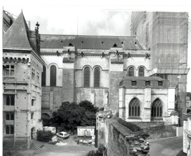
Elévation nord de la nef vue depuis le palais épiscopal (à gauche, l'escalier d'honneur de ce dernier dit escalier Rohan). A droite, flanquant la première travée de la nef, la chapelle Sainte-Anne. Phot. François Lasa IVR52_20014901267V
