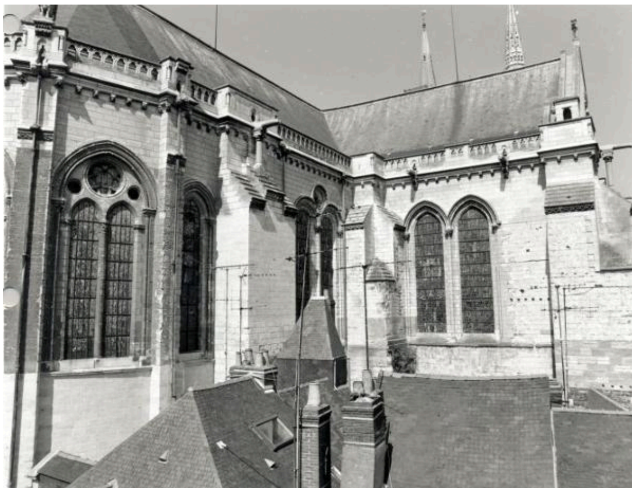
Chevet : élévation extérieur nord et bras nord du transept : élévation extérieure nord.
