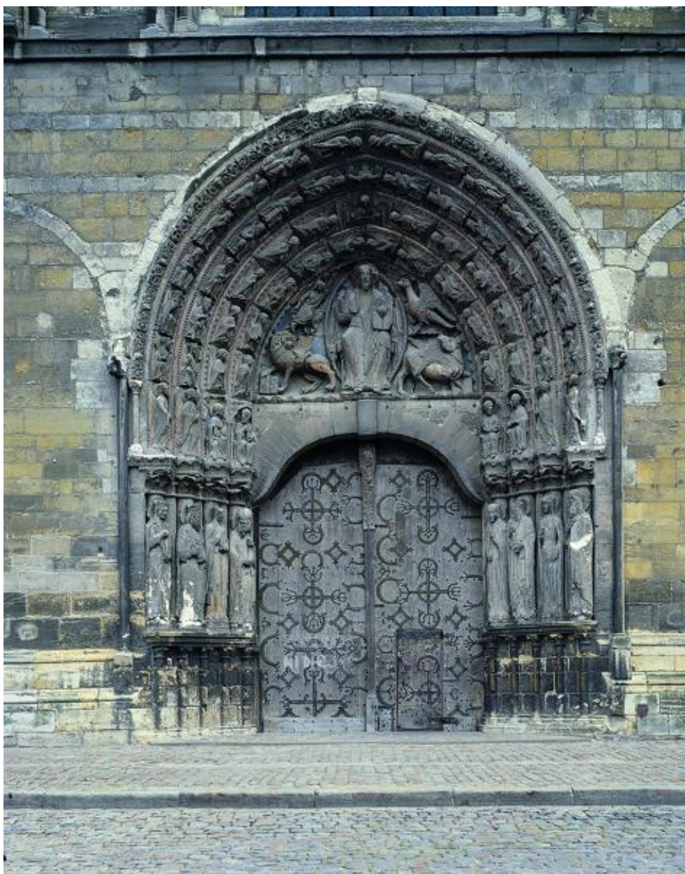
Vue d'ensemble du portail à statues-colonnes : façade occidentale.
