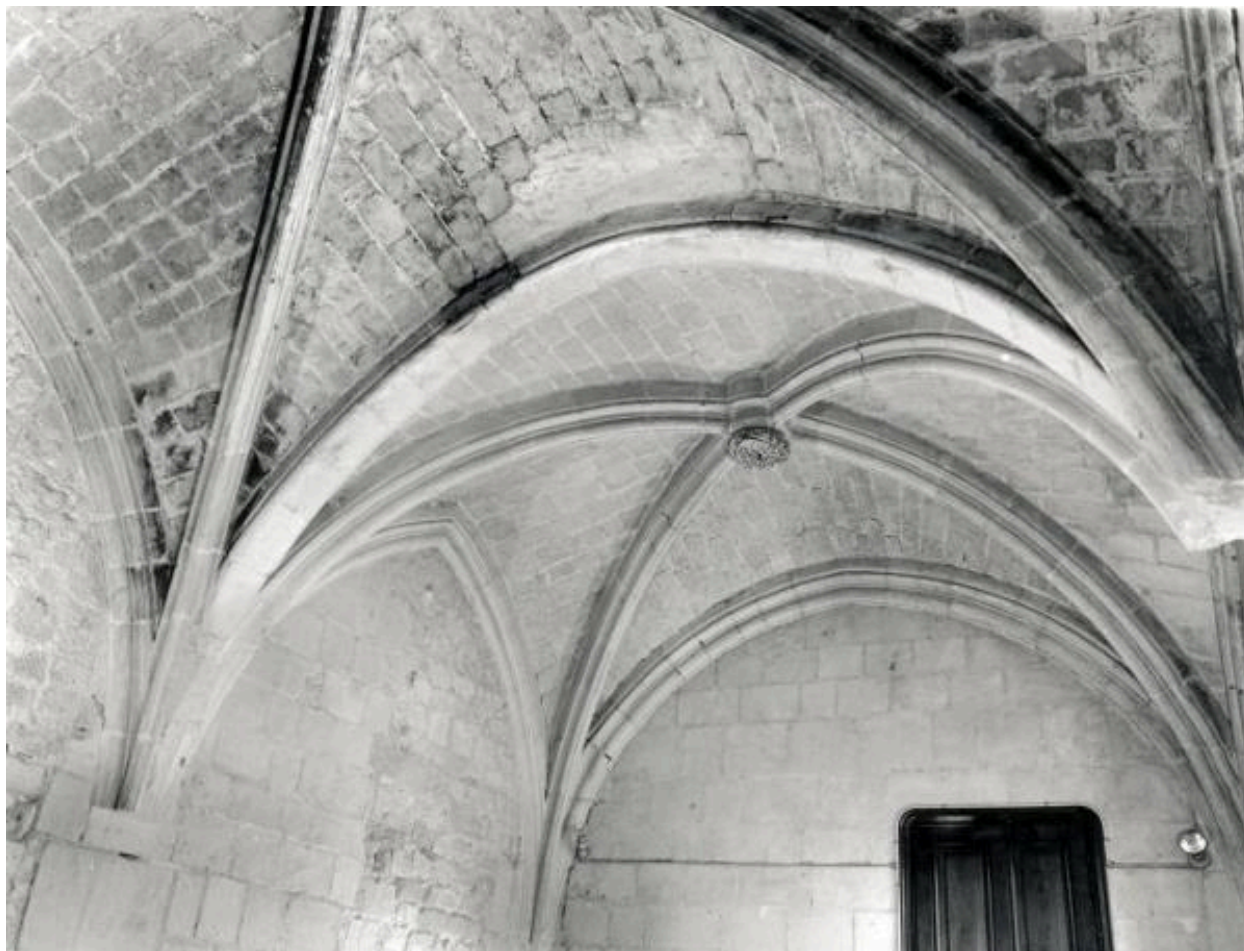
Chapelle Saint-Jean : voûte de la travée est.
