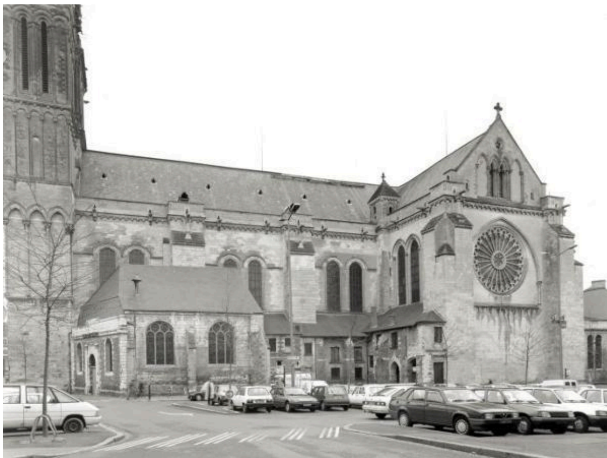
Nef et transept : façade sud.
