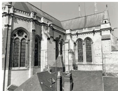
Chevet : élévation extérieure nord et bras nord du transept : élévation extérieure nord. Phot. François Lasa IVR52_19964900724X
