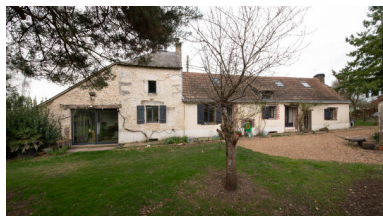
Élévation sur cour du logis. Phot. Thierry Seldubuisson IVR52_20247200177NUCA
