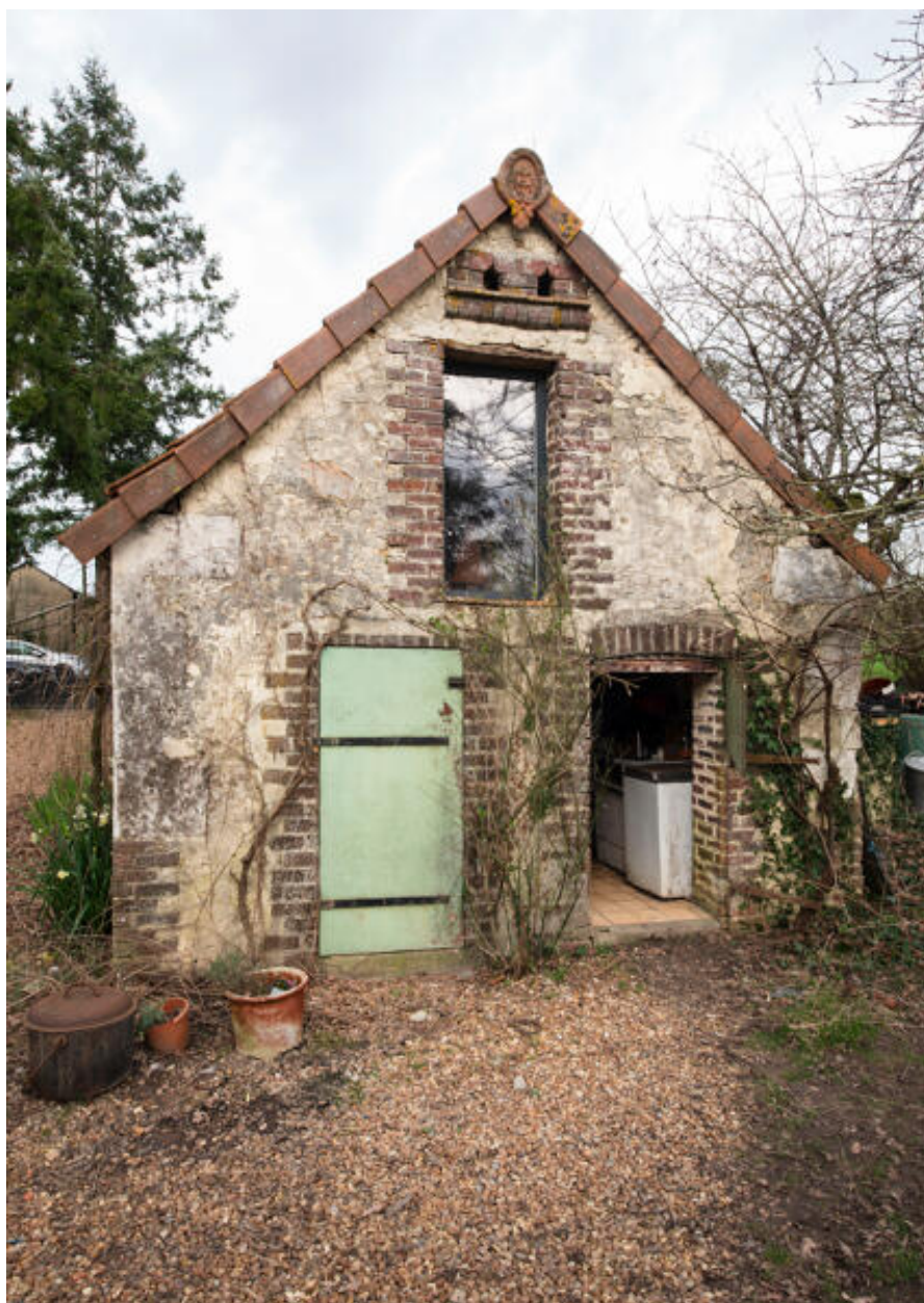
Pignon gauche des étables.
