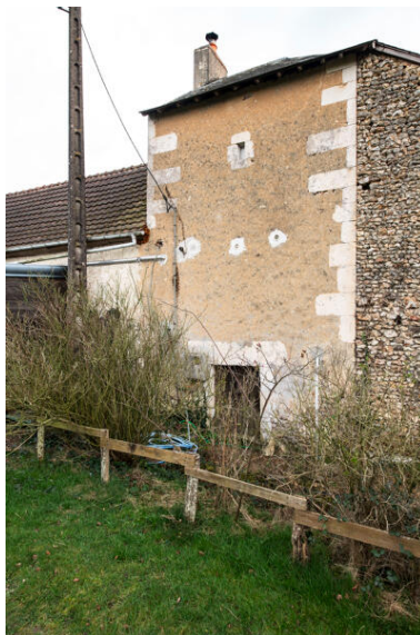
Élévation postérieure du pavillon à étage. Phot. Thierry Seldubuisson IVR52_20247200178NUCA
