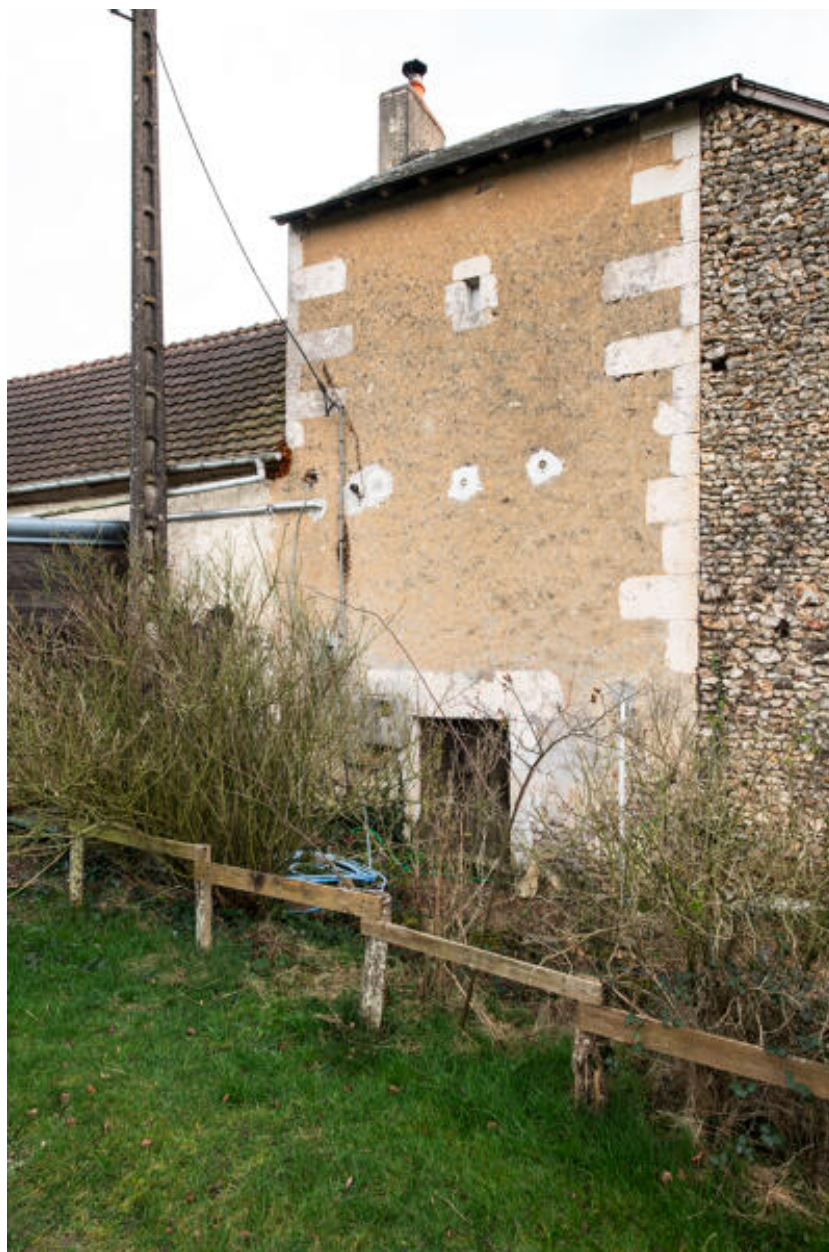
Élévation postérieure du pavillon à étage.
