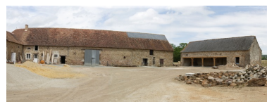
Le corps nord et l'ancien logement-étable vus depuis la cour au sud-ouest. Phot. François Lasa IVR52_20055301942NUCA
