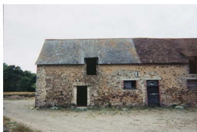
Photographie, vers 2000. L'extrémité sud du corps ouest vue depuis la cour à l'est. Autr. Jean ou Aline Theis, Phot. François Lasa IVR52_20055301952NUCA
