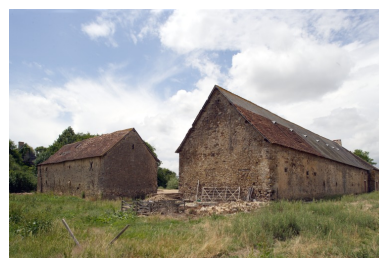
Le corps nord et l'ancien logement-étable vus depuis le nord-est. Phot. François Lasa IVR52_20055301940NUCA
