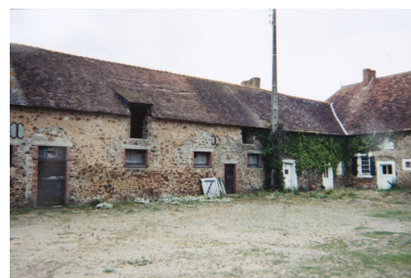
Photographie, vers 2000. Le corps ouest et la partie du corps nord abritant le logis vus depuis la cour au sud-est. Autr. Jean ou Aline Theis, Phot. François Lasa IVR52_20055301949NUCA
