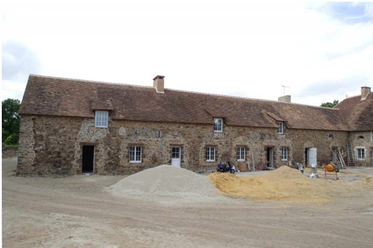
Le corps ouest vu depuis la cour à l'est.
