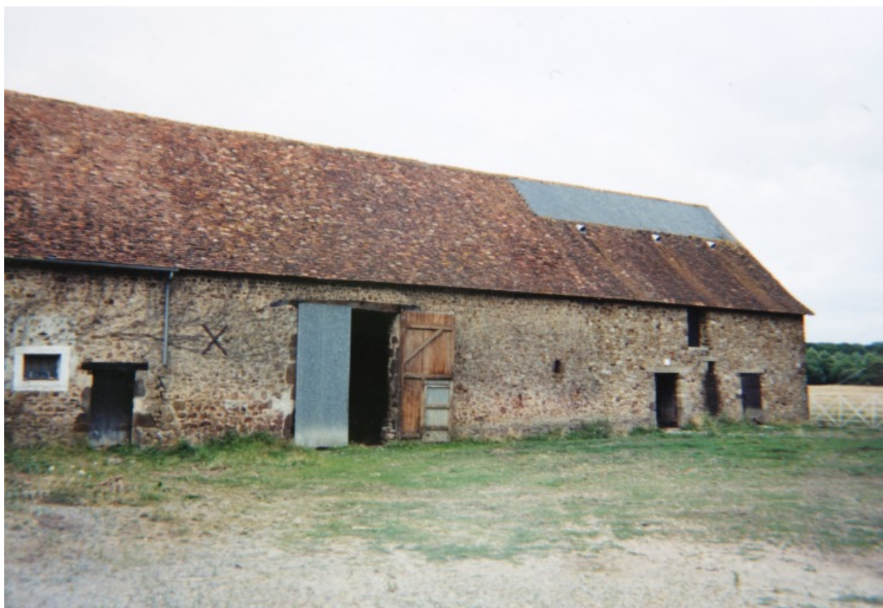
Photographie, vers 2000. Le corps nord vu depuis la cour au sud.
