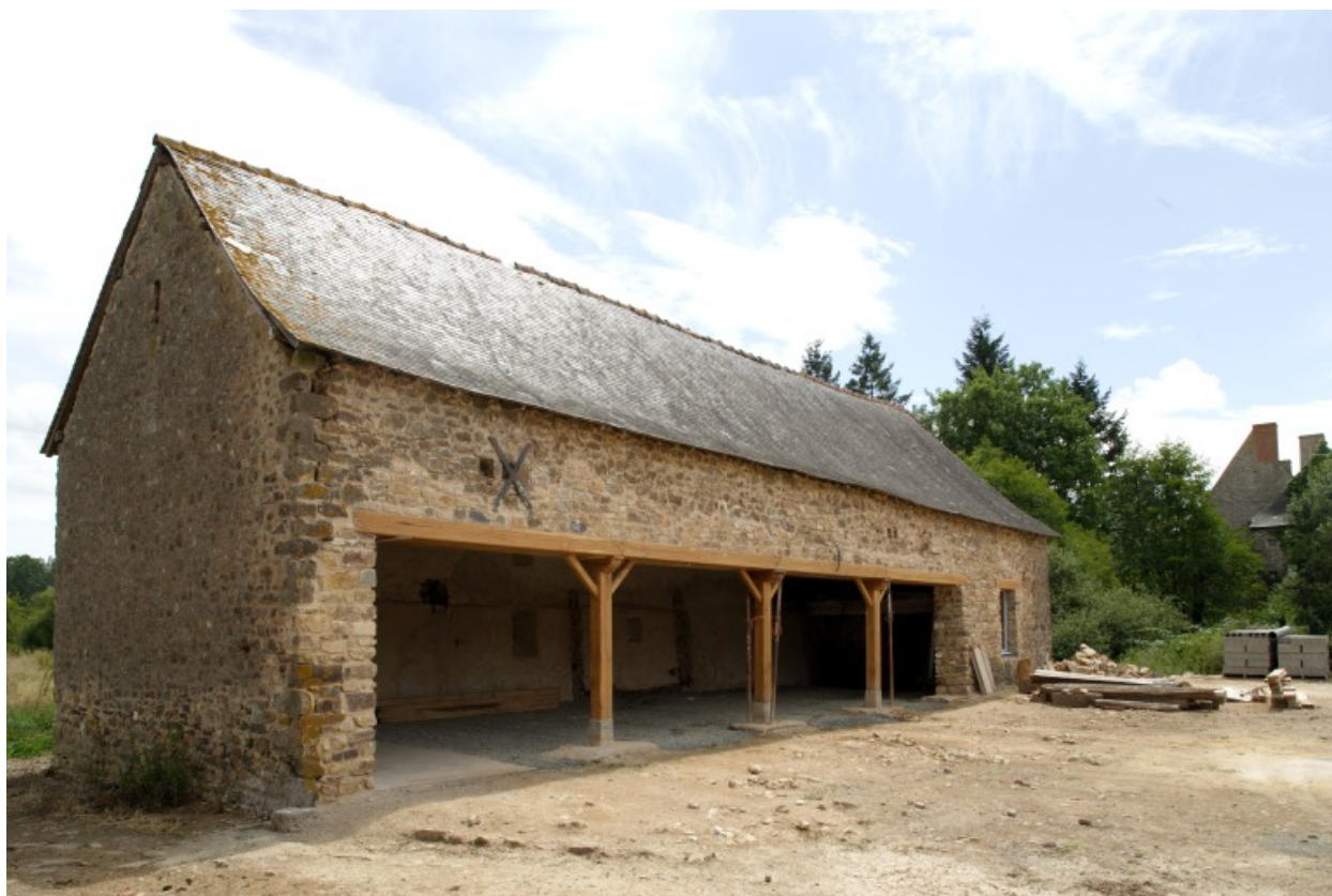
L'ancien logement-étable, aujourd'hui garage, vu depuis la cour au nord-ouest.
