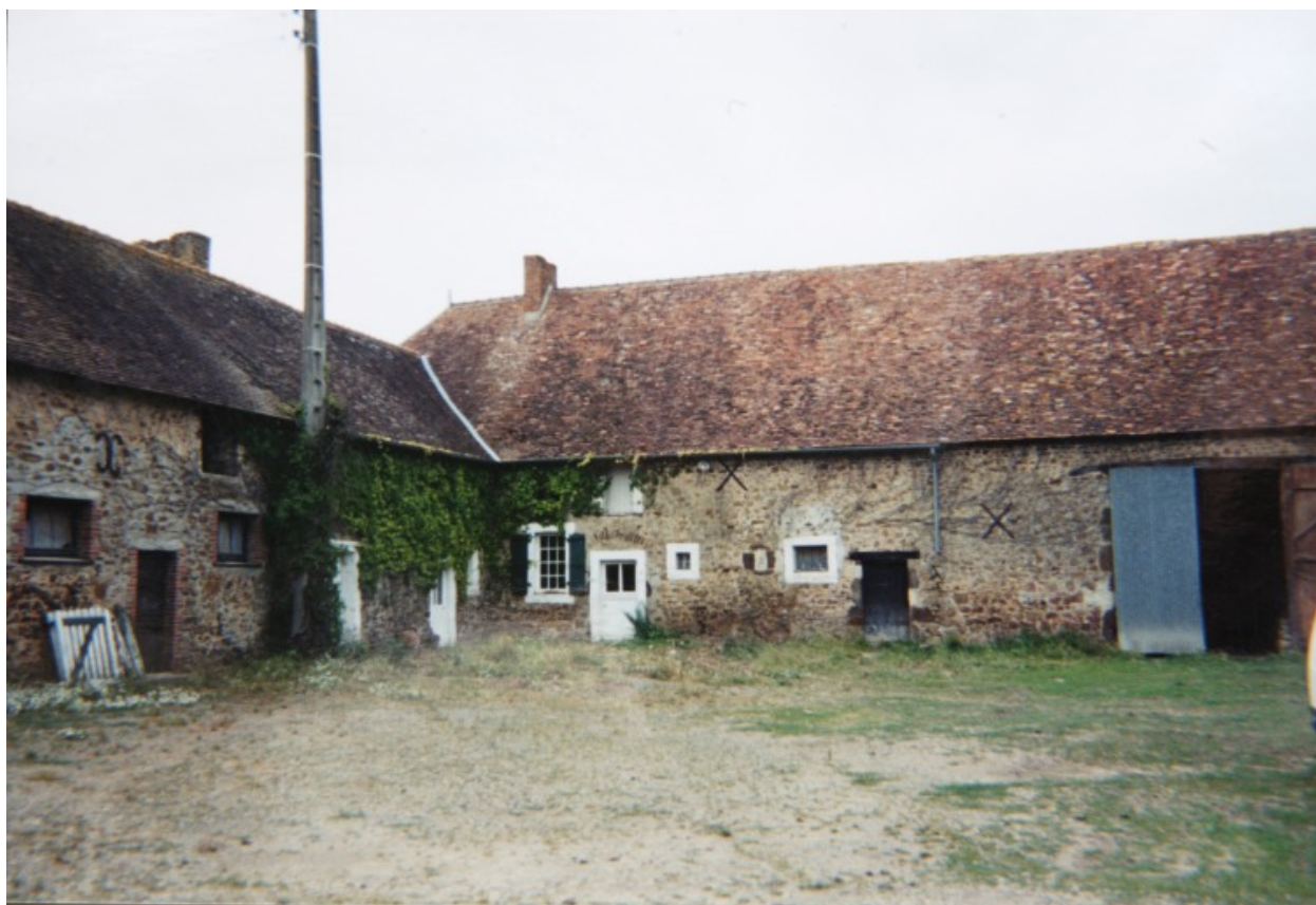
Photographie, vers 2000. Le logis vu depuis la cour au sud-est.
