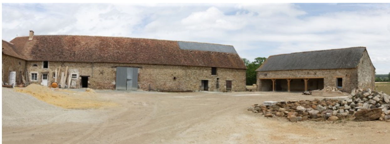
Le corps nord et l'ancien logement-étable vus depuis la cour au sud-ouest.
