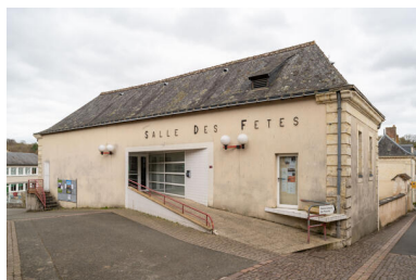
Entrée de la salle des fêtes à l'ouest. Phot. Jeanne Minier IVR52_20267200314NUCA
