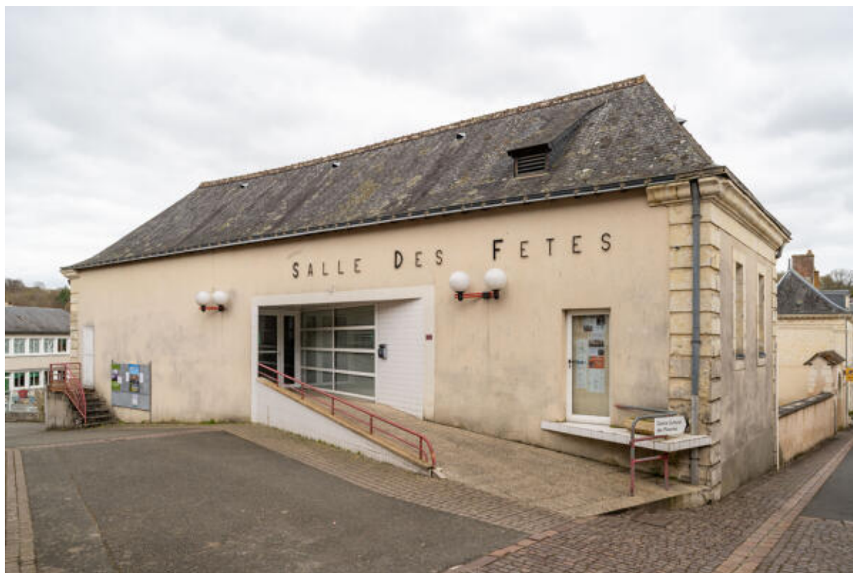
Entrée de la salle des fêtes à l'ouest.
