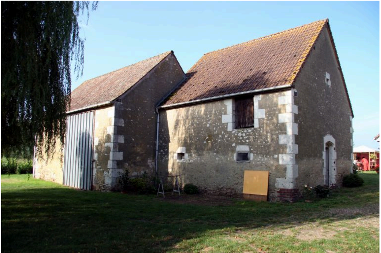
Nouvelles écuries et la grange construite en 1891 ?
