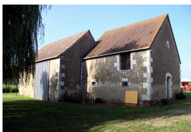
Nouvelles écuries et la grange construite en 1891 ? Phot. Jean-Baptiste Darrasse IVR52_20057202925NUCA
