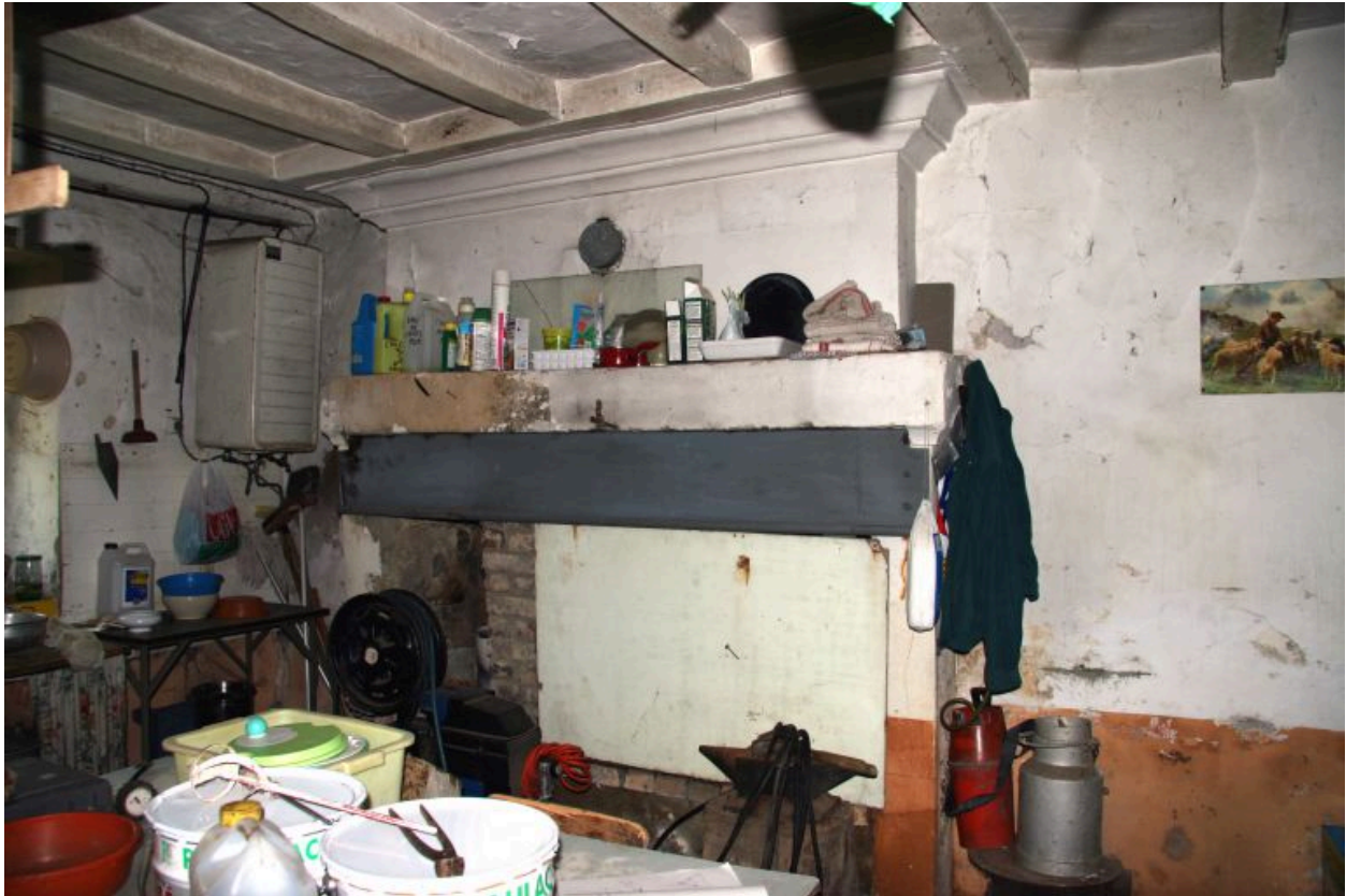
L'habitation : cheminée de la pièce à vivre.
