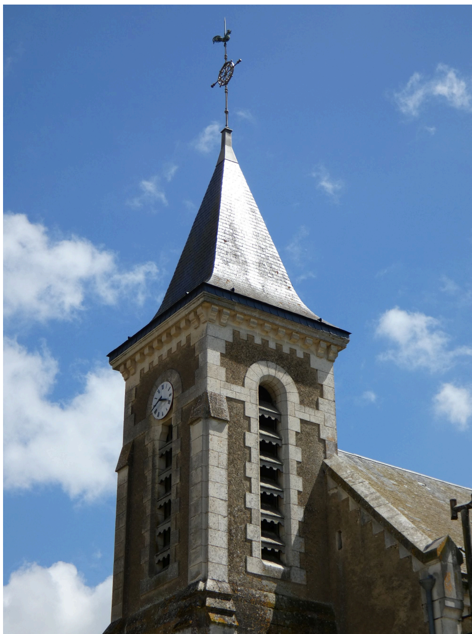
Le clocher vu depuis le nord-ouest.
