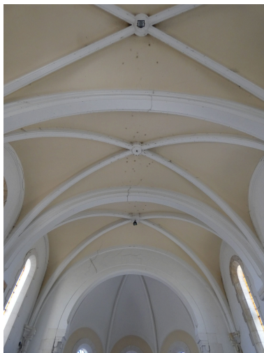
La voûte de la nef. Phot. Yannis Suire IVR52_20238500002NUCA
