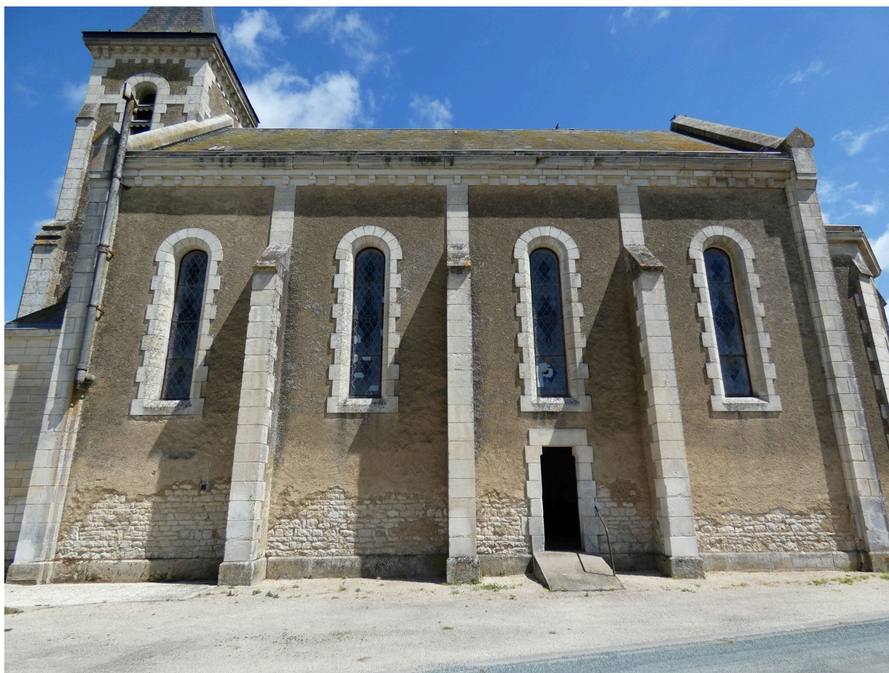
L'élévation ouest de la nef.
