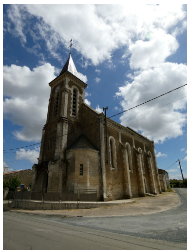
L'église vue depuis le nord-ouest. Phot. Yannis Suire
