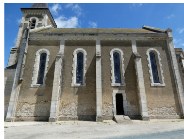
L'élévation ouest de la nef.
