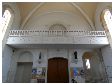
La tribune au-dessus de l'entrée principale. Phot. Yannis Suire IVR52_20238500005NUCA
