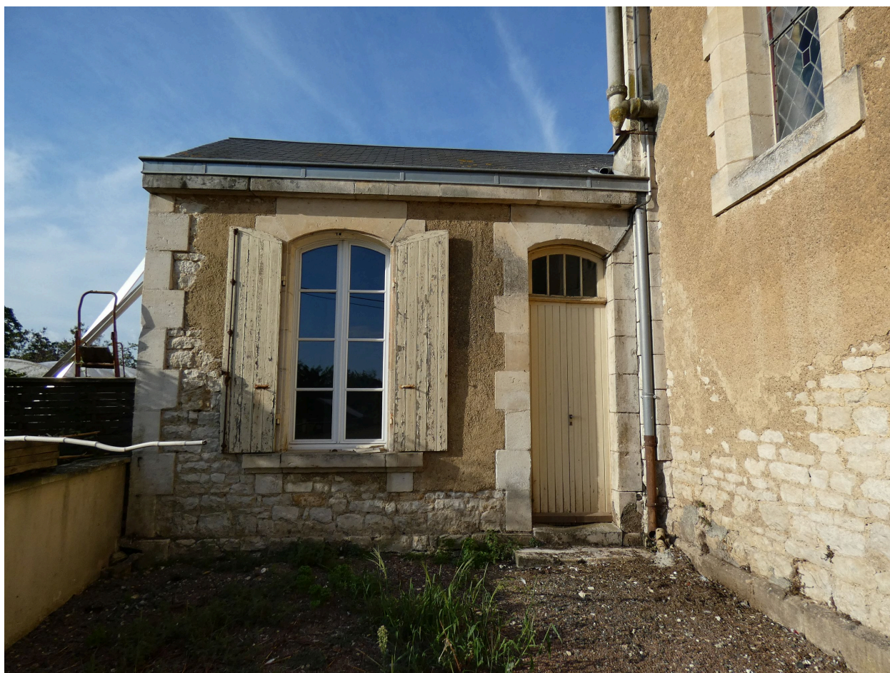
La sacristie vue depuis le nord-est.
