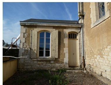
La sacristie vue depuis le nord-est.
