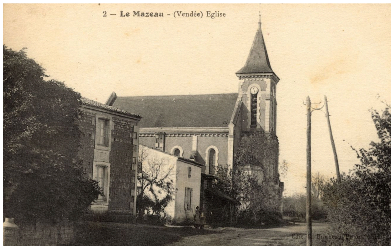
L'église vue depuis l'est vers 1930.
