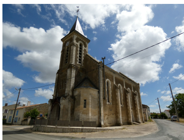
L'église vue depuis le nord-ouest. Phot. Yannis Suire IVR52_20228501617NUCA
