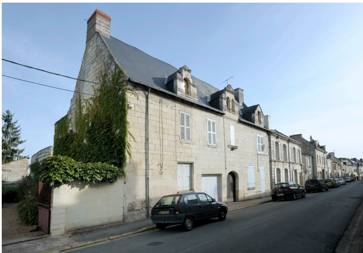
Rue Robert-d'Arbrissel, côté nord, dont l'allotissement du tronçon central commença à la fin du XVI e siècle.
