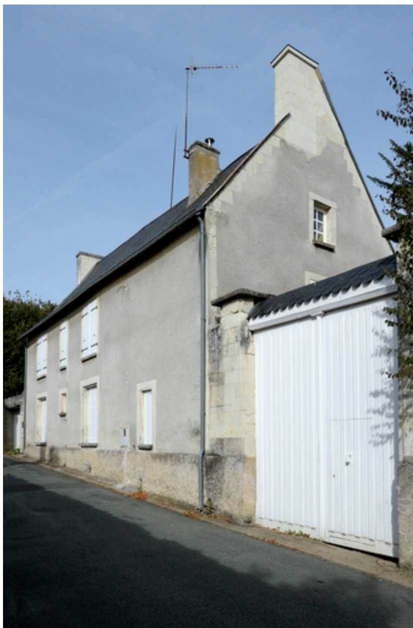
Impasse des Moulins, ancien logis des officiers forestiers de l'abbaye (sans doute 17 e siècle, très remanié).
