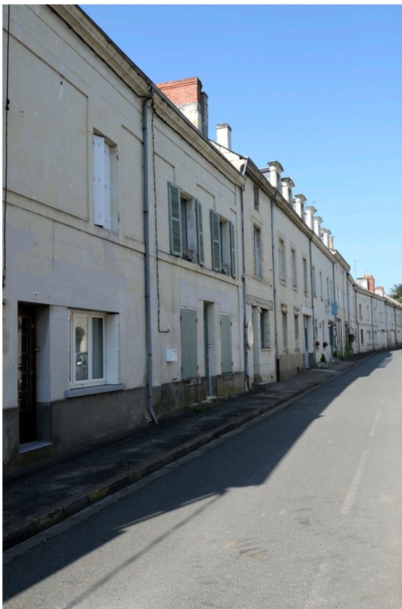
Rue Robert-d'Arbrissel, côté sud : les maisons au premier-plan, aux façades sobres, sont construites au XIXe siècle sur l'emplacement de l'ancien cimetière.
