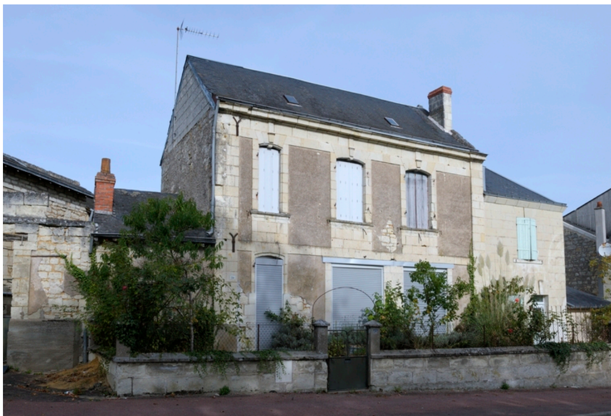
24, avenue du 11-Novembre-1918, maison du 1er quart du 18e siècle (très remaniée).
