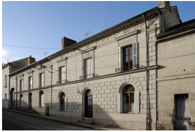
Exemple de maison du XIXe siècle alignée sur l'avenue Rochechouart : ensemble bâti des 21 et 23, avenue Rochechouart.
