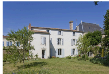
Façade est, donnant sur le jardin. Phot. Patrice Giraud IVR52_20098500404NUCA
