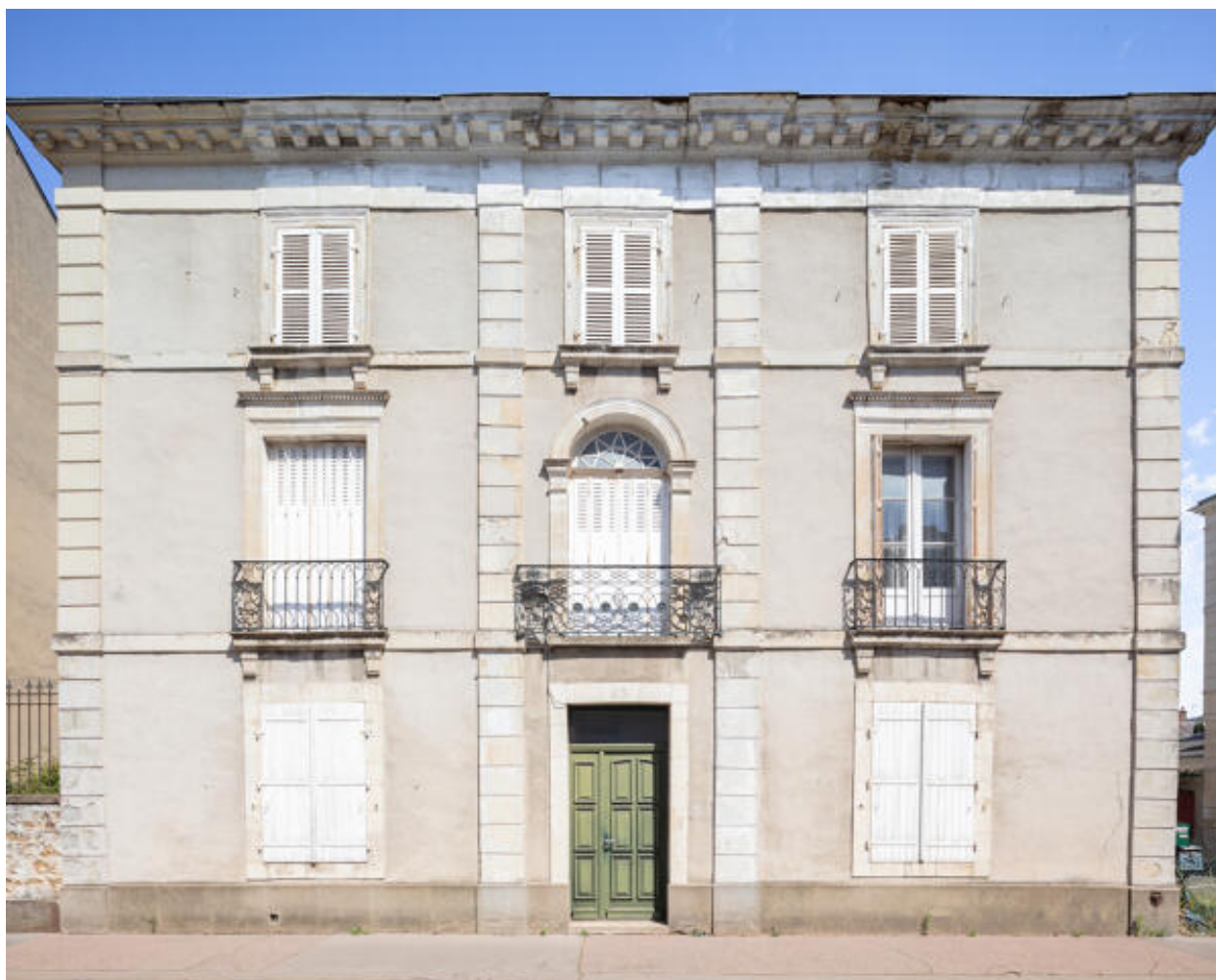
Vue de la façade principale de la maison au croisement de la rue Chanzy et de la rue Scarron.
