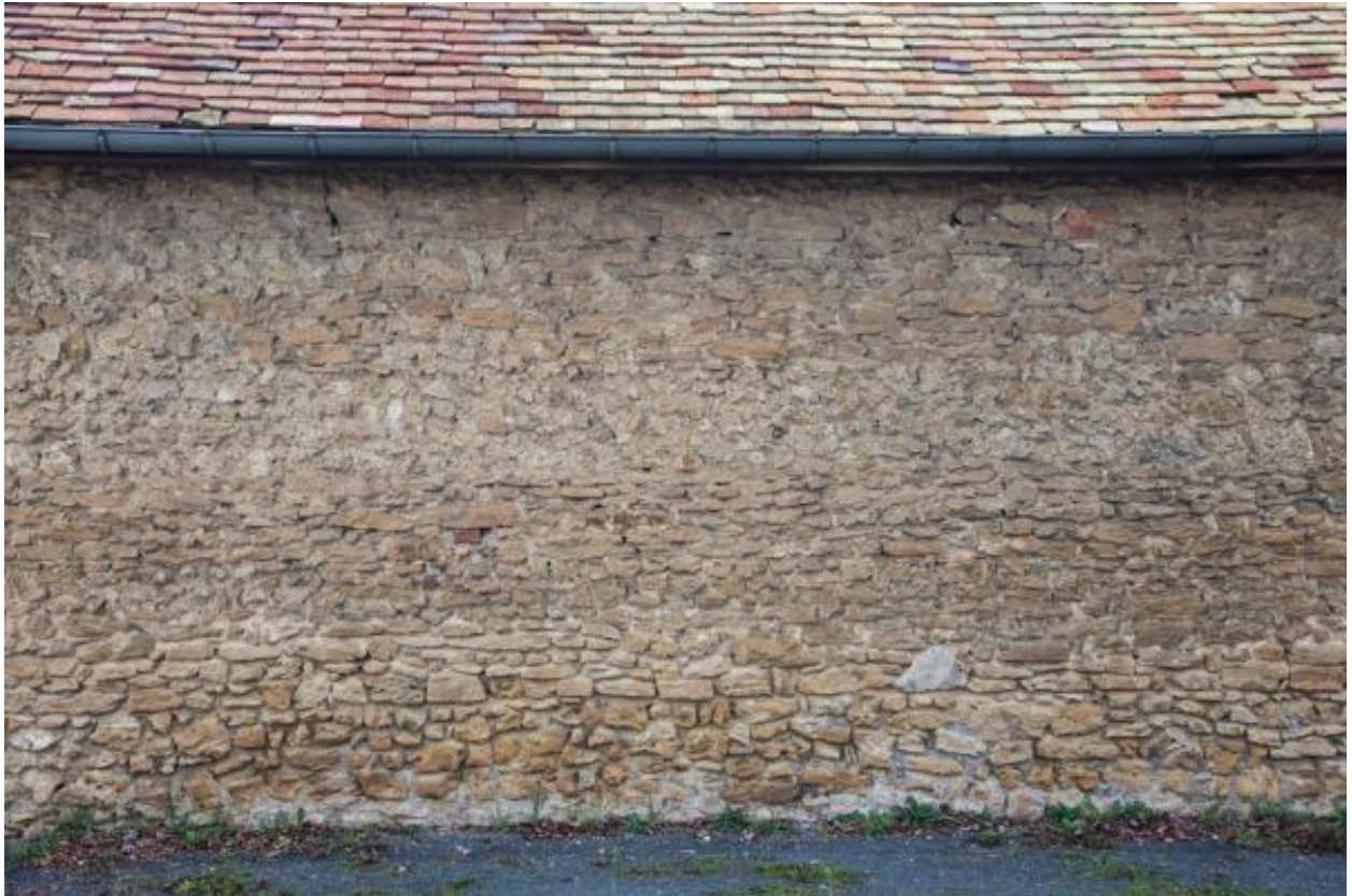
Vue des moellons de construction du mur donnant route de l'Eventail.
