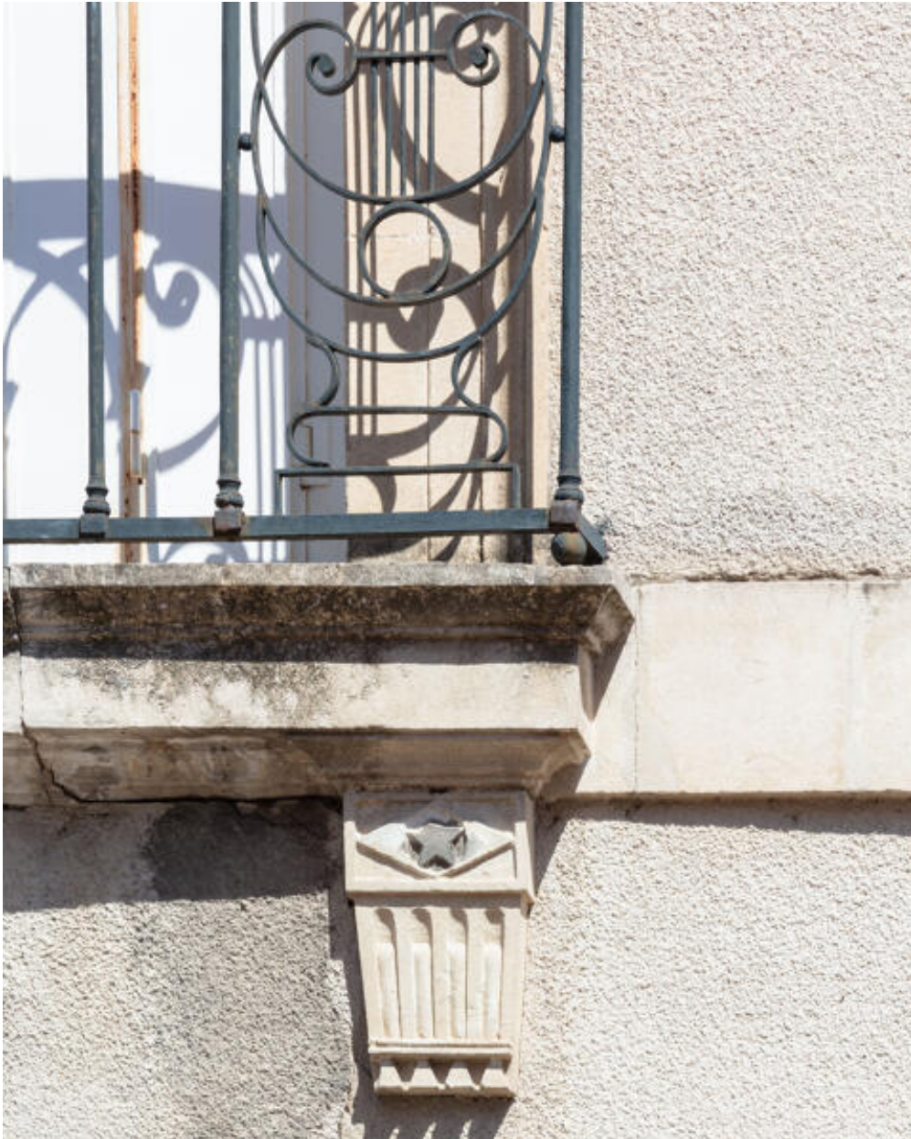
Détail de balcon de premier étage de la maison au croisement de la rue Chanzy et de la rue Scarron.
