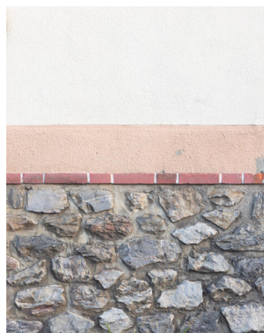
Détail des matériaux des maisons économiques construites par Paul Grosch rue de l'Eventail. Phot. Paul Hamelin IVR52_20227200844NUCA
