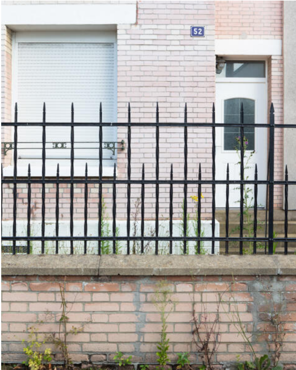
Détail de la grille et du muret en alignement de la rue, devant les maisons économiques rue de l'Eventail.
