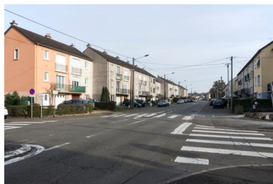
Vue du lotissement Leroi et Haricot rue de l'Eventail. Phot. Bruno Rousseau IVR52_20207200947NUCA
