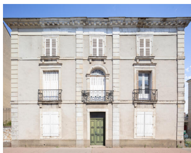
Vue de la façade principale de la maison au croisement de la rue Chanzy et de la rue Scarron. Phot. Paul Hamelin IVR52_20227200884NUCA
