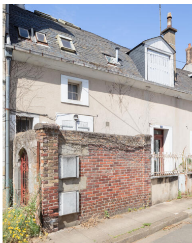
Vue de la maison au numéro 1 rue Scarron. Phot. Paul Hamelin IVR52_20227200886NUCA
