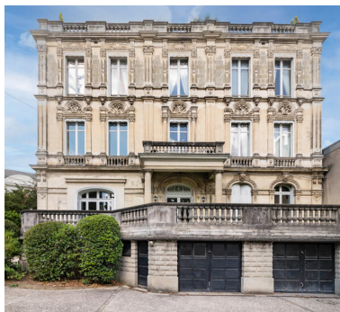
Demeure dite Pellier, avenue Bollée. Phot. Thierry Seldubuisson IVR52_20227200948NUCA
