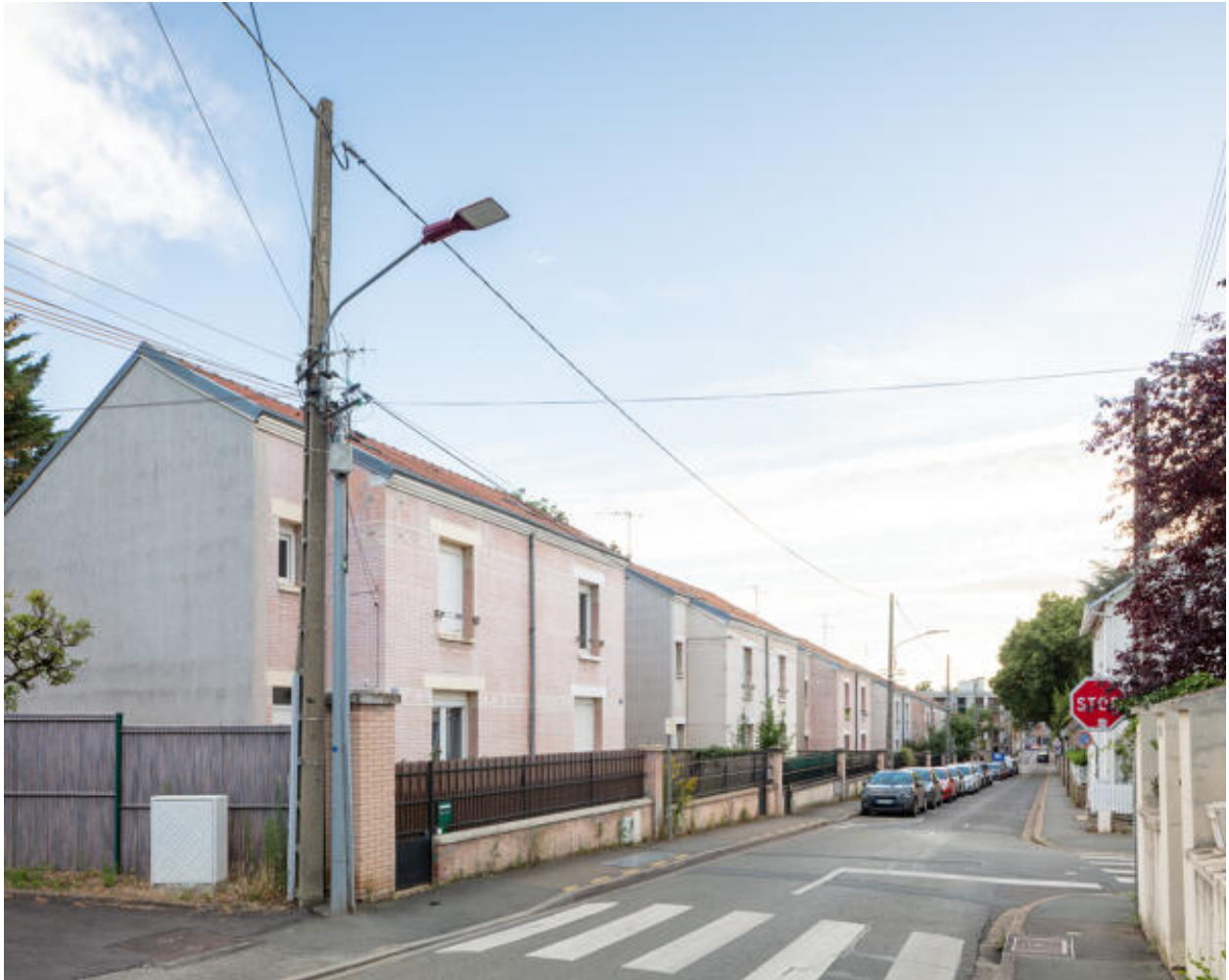
Vue des maisons économiques rue de l'Eventail.
