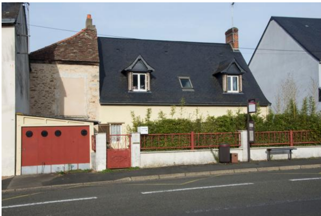
Vue de la ferme dite de l'Ardoise.
