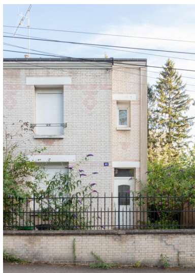
Vue d'une maison économique rue de l'Eventail. Phot. Paul Hamelin IVR52_20227200842NUCA
