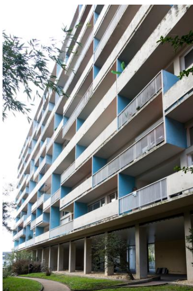
Vue de la façade est de la résidence du Parc. Phot. Bruno Rousseau IVR52_20207201029NUCA
