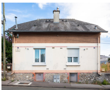
Vue de la façade latérale d'une maison double construite par Paul Grosch rue de l'Eventail. Phot. Paul Hamelin IVR52_20227200846NUCA
