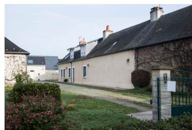
Vue d'anciens corps de ferme route de l'Eventail. Phot. Bruno Rousseau IVR52_20207200943NUCA
