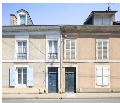
Vue de deux maisons rue Flore. Phot. Paul Hamelin IVR52_20227200824NUCA
