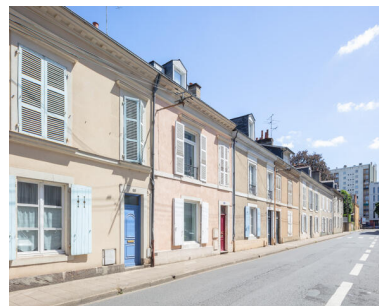
Alignement des maisons rue Flore. Phot. Paul Hamelin IVR52_20227200825NUCA
