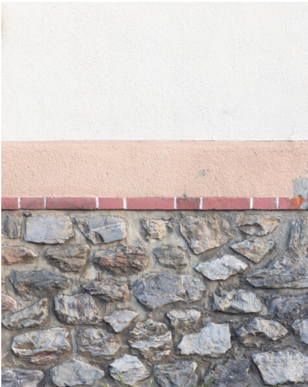
Détail des matériaux des maisons économiques construites par Paul Grosch rue de l'Eventail.
