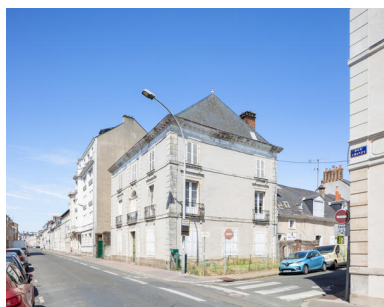
Vue de la maison au croisement de la rue Chanzy et de la rue Scarron. Phot. Paul Hamelin IVR52_20227200880NUCA
