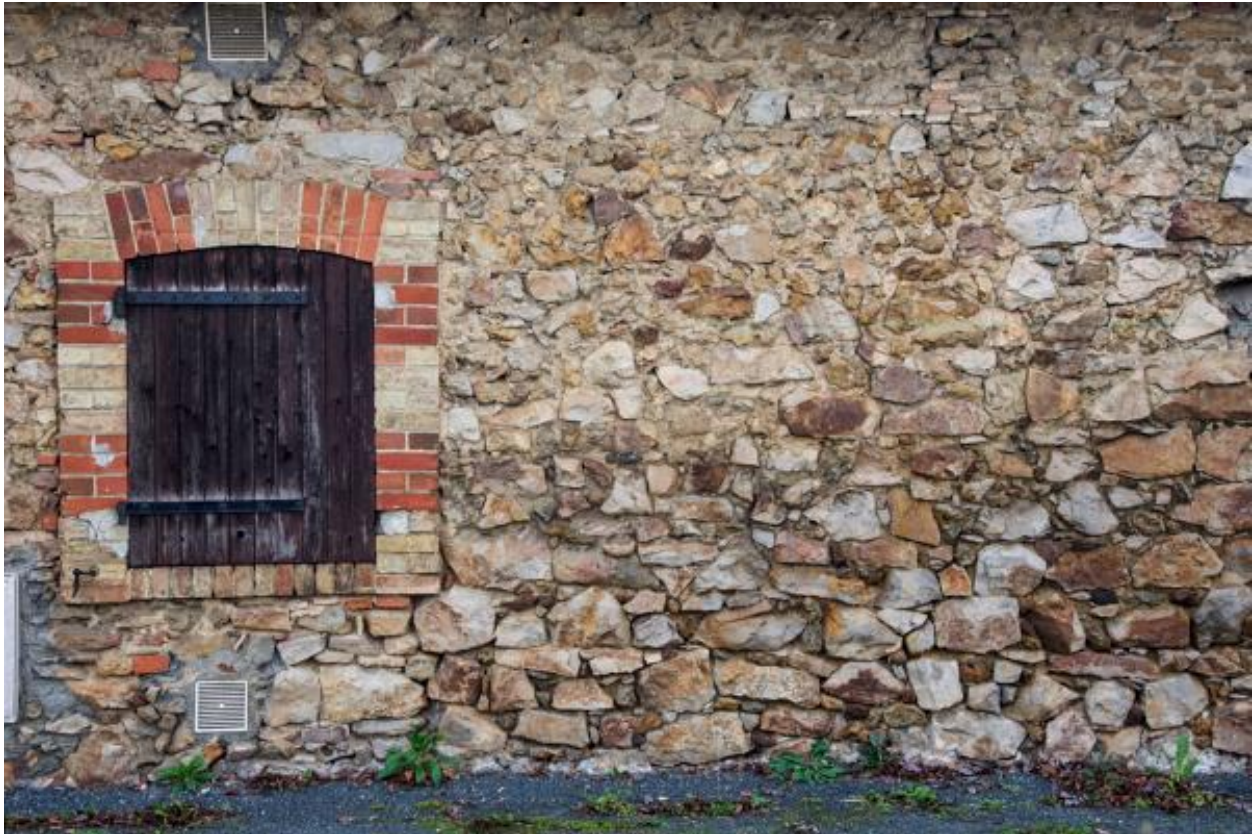
Détail d'un ancien corps de ferme route de l'Eventail.
