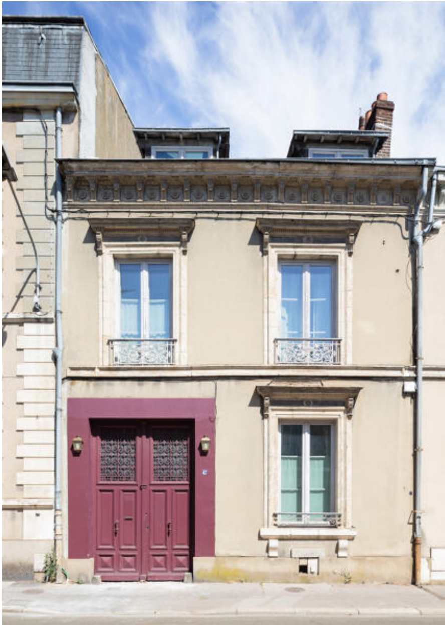
Vue d'une maison construite par Poivet rue Chanzy.
