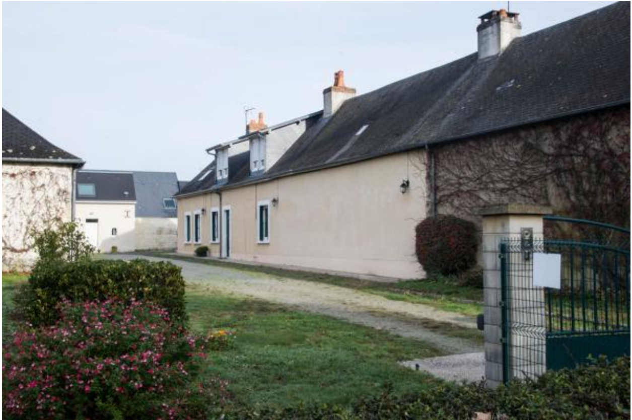
Vue d'anciens corps de ferme route de l'Eventail.
