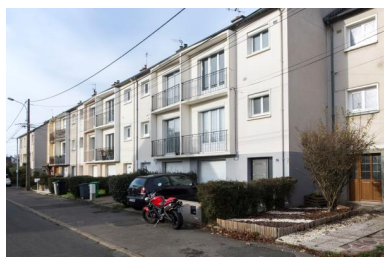
Vue du lotissement Leroi et Haricot rue Bobby-Sachs. Phot. Bruno Rousseau IVR52_20207200949NUCA
