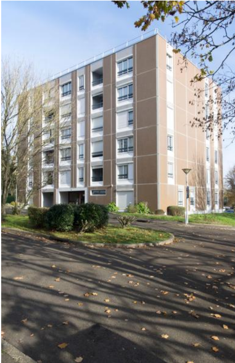
Vue d'une des deux tours avec parement en céramique rue Marivaux.
