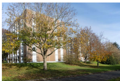
Vue des tours avec parement céramique rue Marivaux. Phot. Bruno Rousseau IVR52_20207200978NUCA
