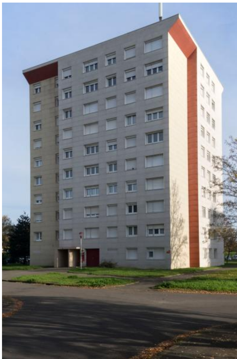
Vue d'une des trois tours construites avenue Bollée.
