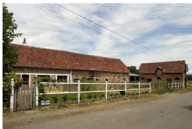
Le logis-étable et la seconde étable vues depuis la route au sud-ouest. Phot. François Lasa IVR52_20055301936NUCA
