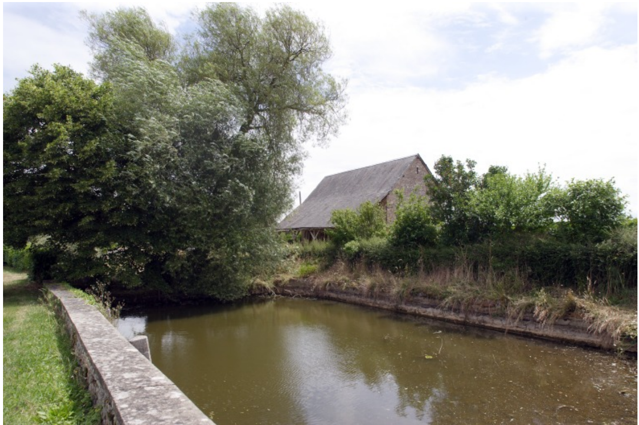
La mare et la remise vues depuis la route au nord-ouest.
