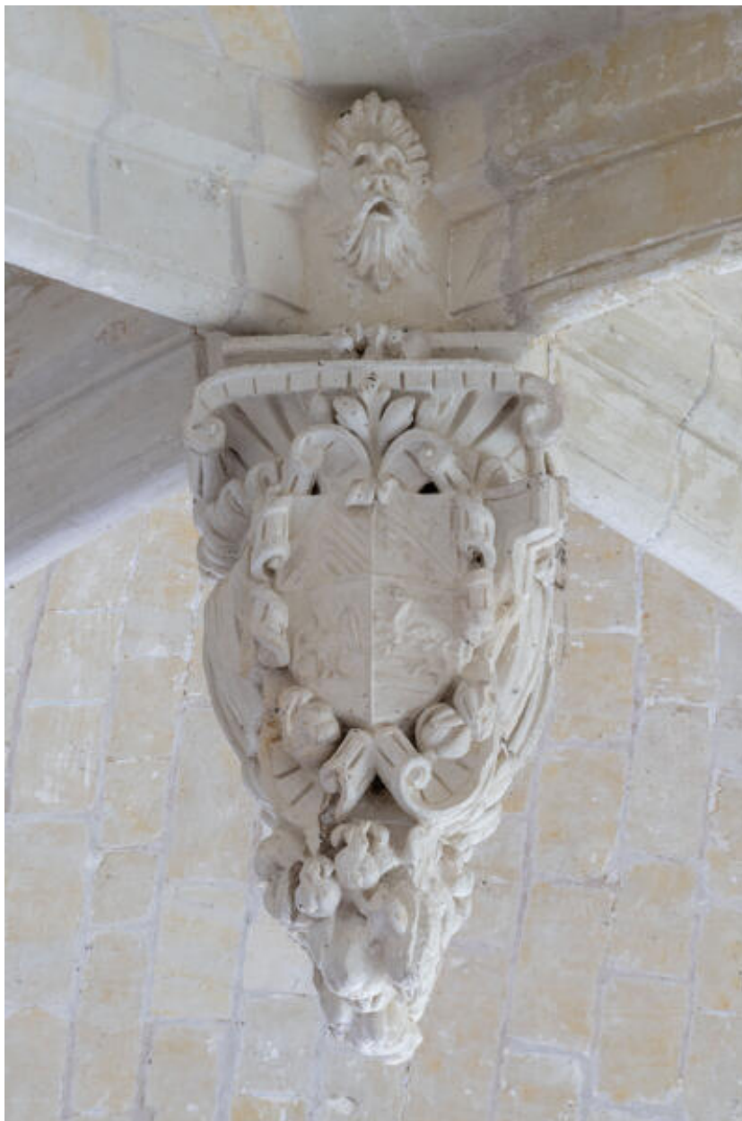
Chapelle latérale, travée est : clef pendante au centre de la voûte.
