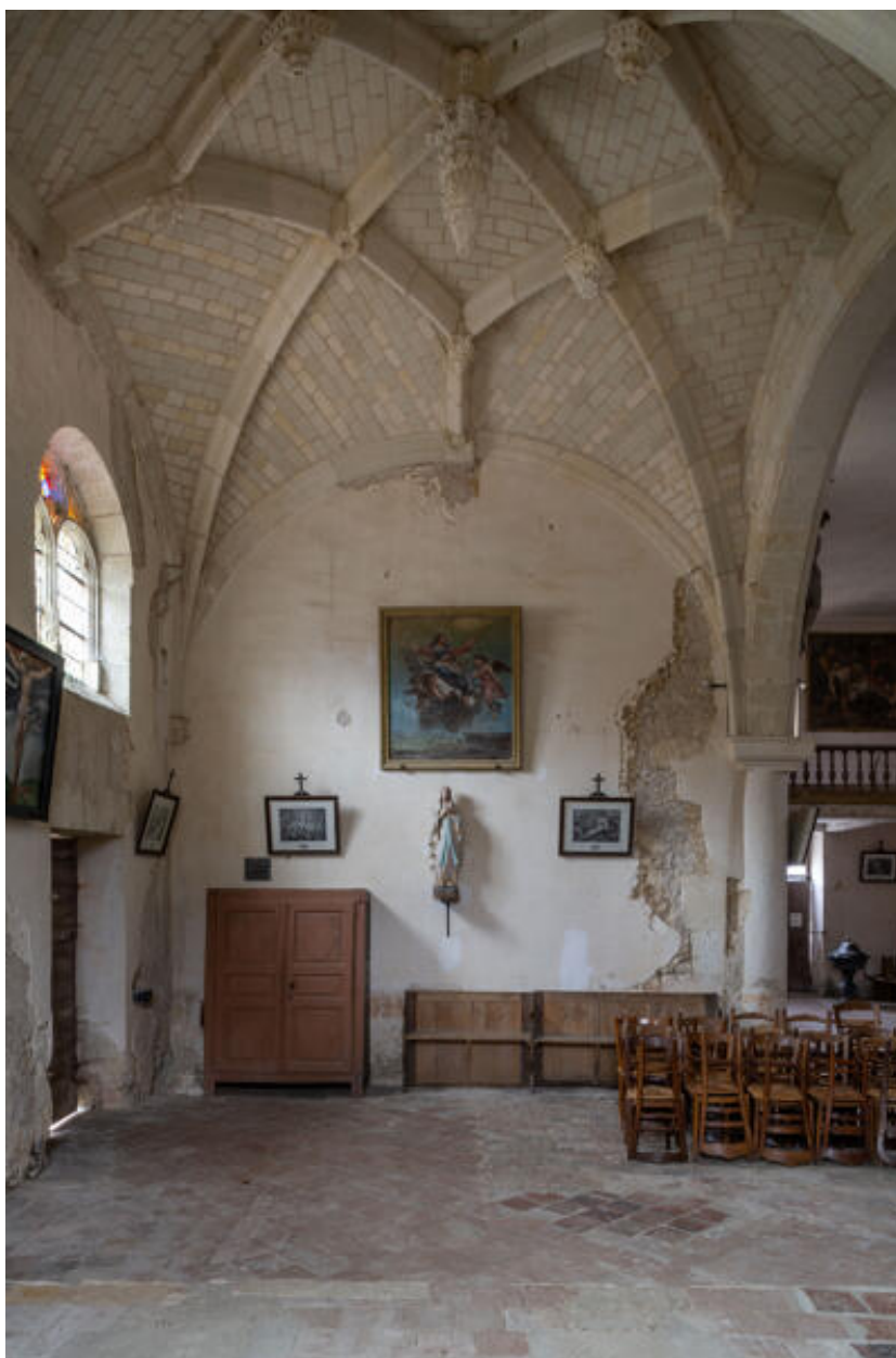
Chapelle latérale : travée ouest.
