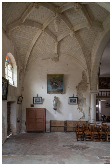
Chapelle latérale : travée ouest.
