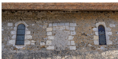
Mur extérieur de la nef, côté nord : baies romanes et vestige de contrefort.
