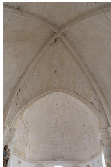
Voûtes du chœur et de l'abside. Phot. Jeanne Minier IVR52_20257200353NUCA
