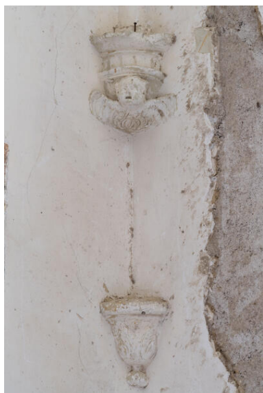
Chapelle latérale : retombée de voûte.
