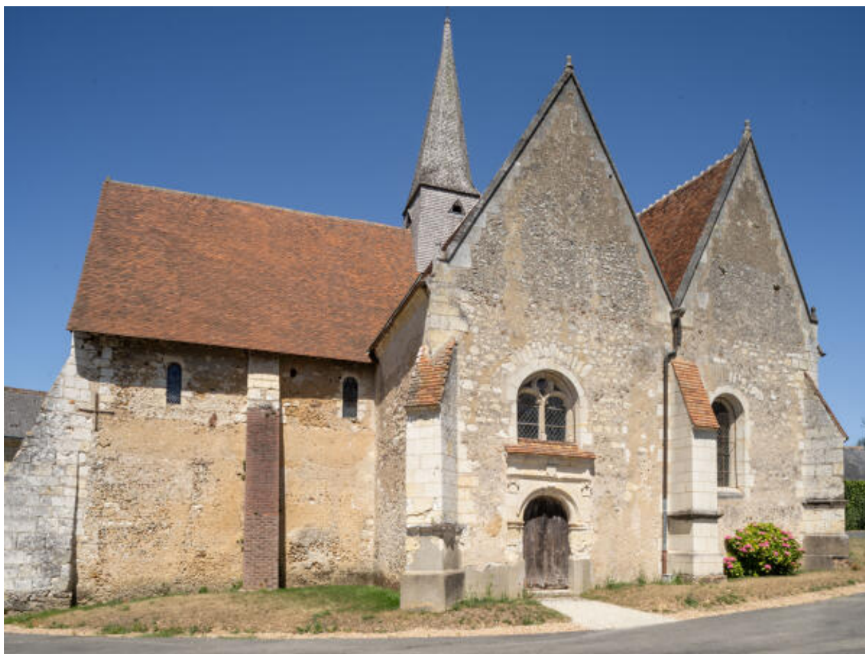
Vue d'ensemble côté sud.
