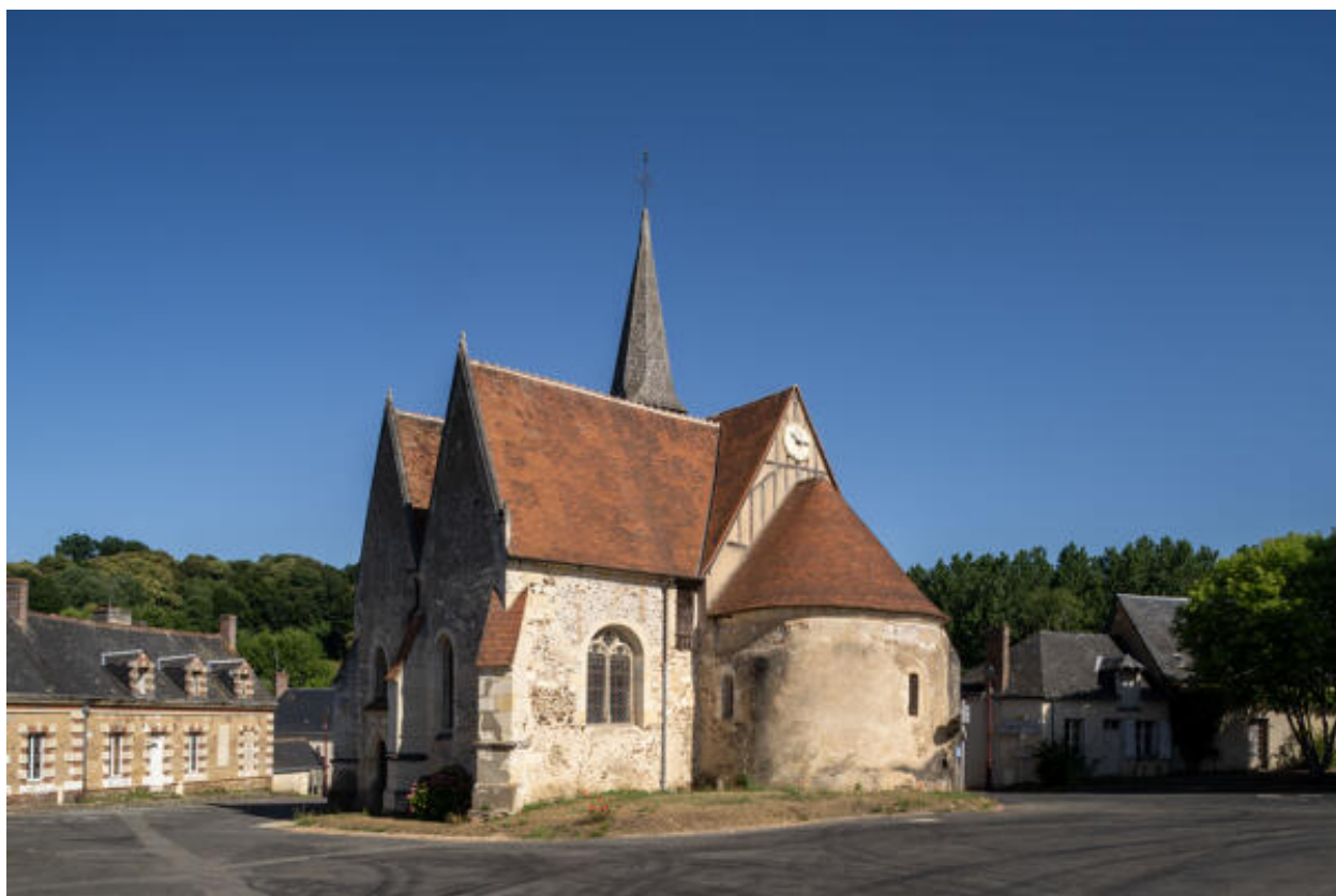
Vue d'ensemble côté sud-est.
