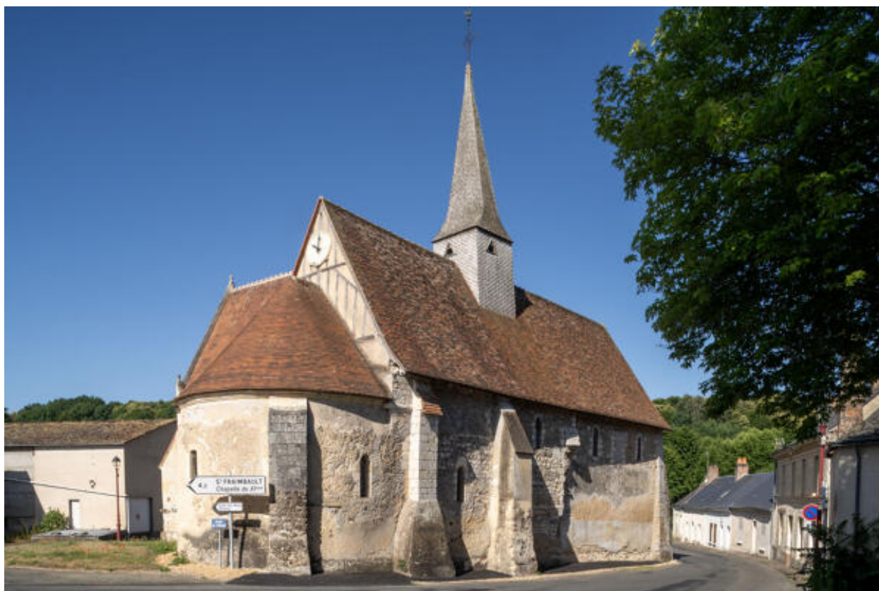
Vue d'ensemble côté nord-est.
