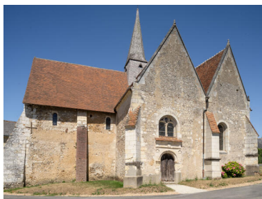
Vue d'ensemble côté sud. Phot. Jeanne Minier IVR52_20257200336NUCA
