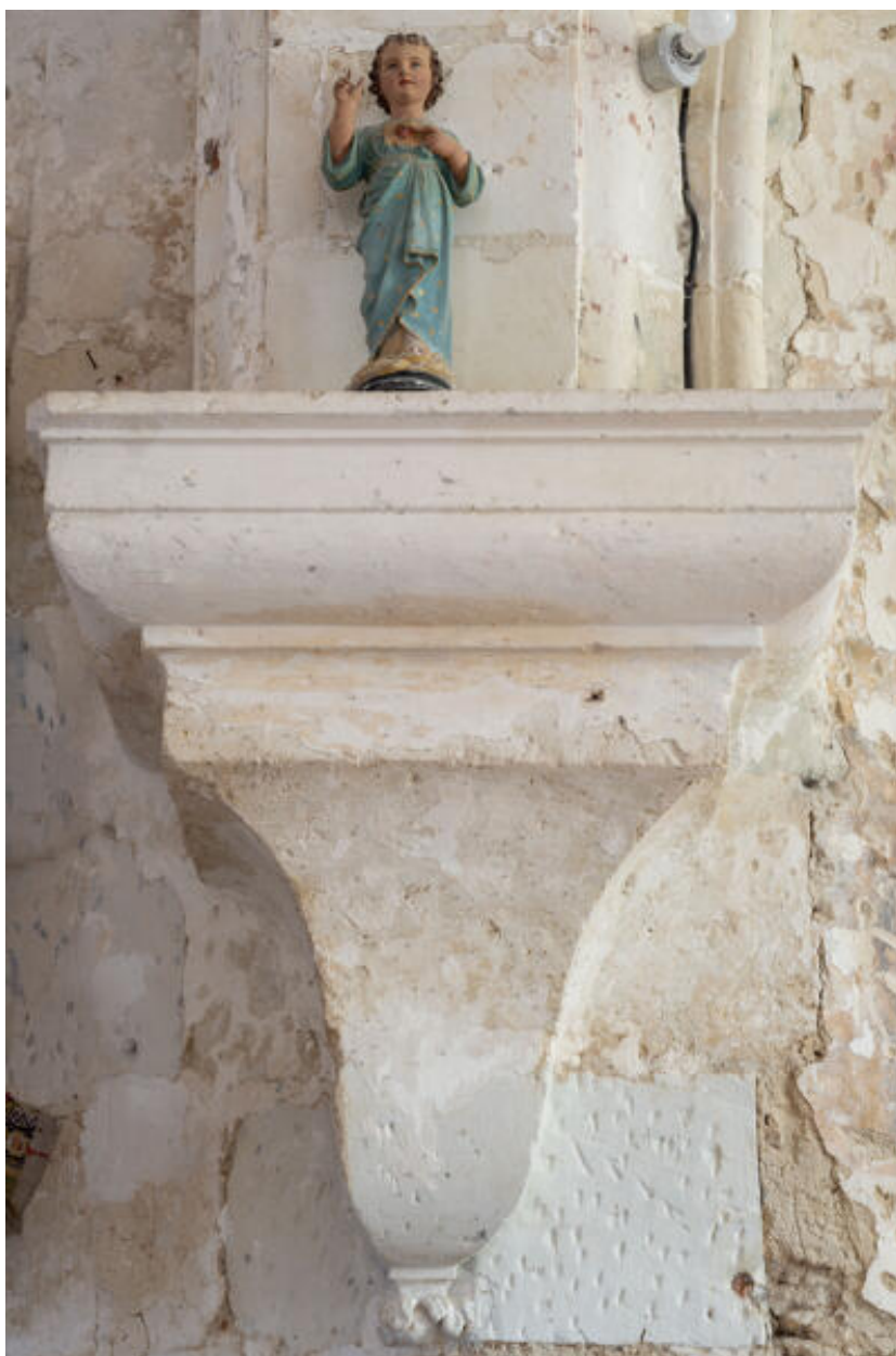
Retombée de voûte entre le chœur et la chapelle.
