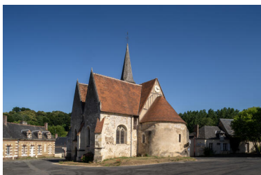
Vue d'ensemble côté sud-est. Phot. Jeanne Minier IVR52_20257200335NUCA
