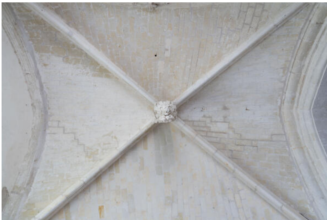
Chapelle latérale : voûte de la travée est.
