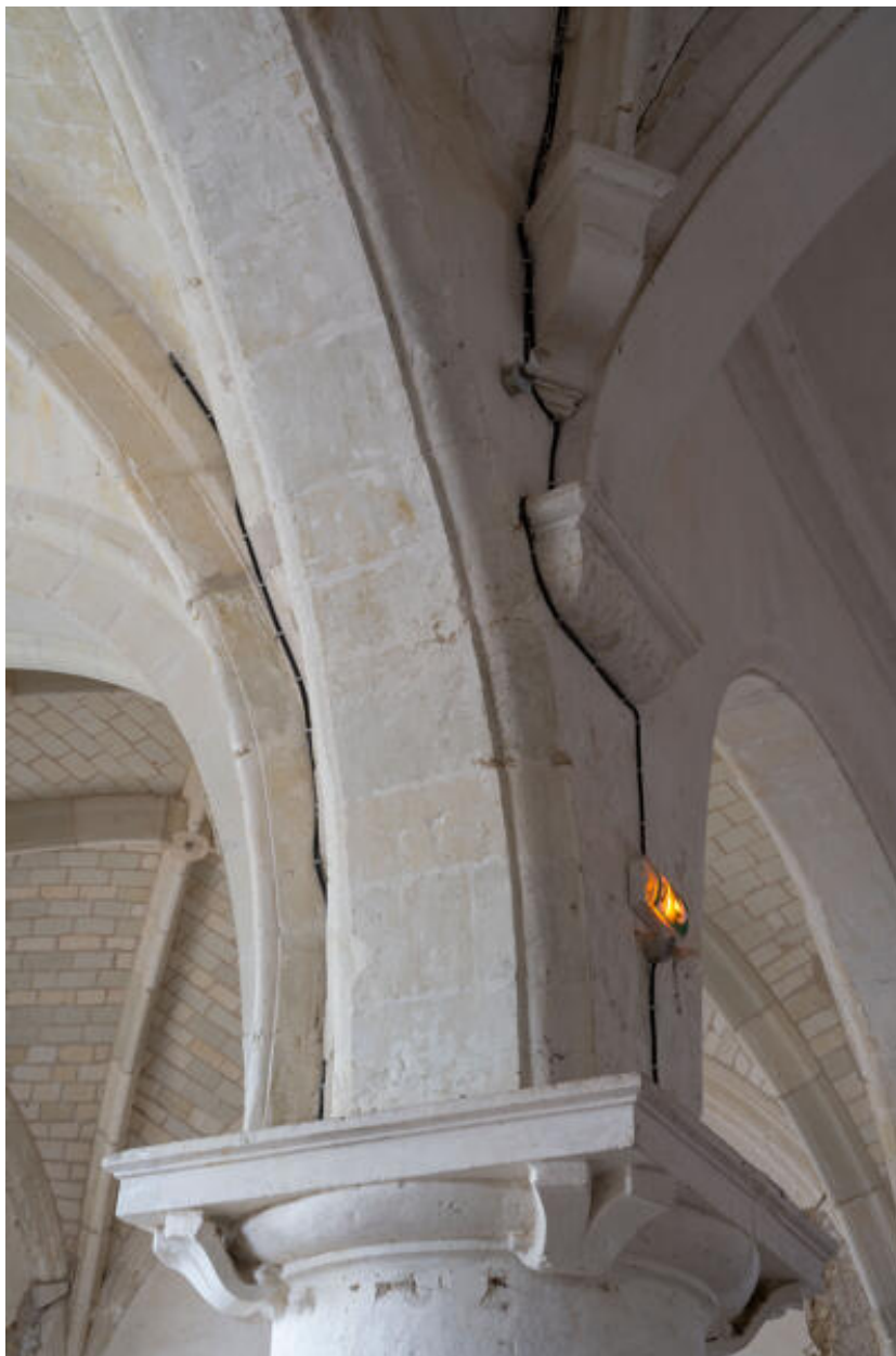
Retombées de voûtes sur pilier central entre la nef, le chœur et la chapelle.
