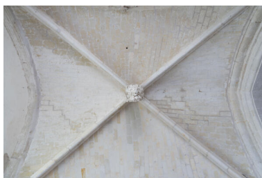
Chapelle latérale : voûte de la travée est.
