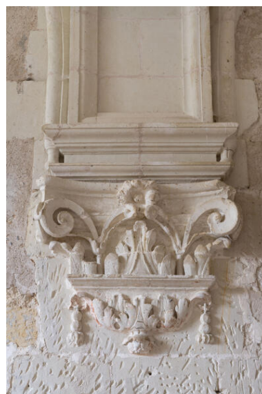
Chapelle latérale : retombée de voûte.
