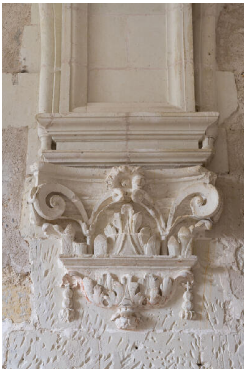
Chapelle latérale : retombée de voûte.
