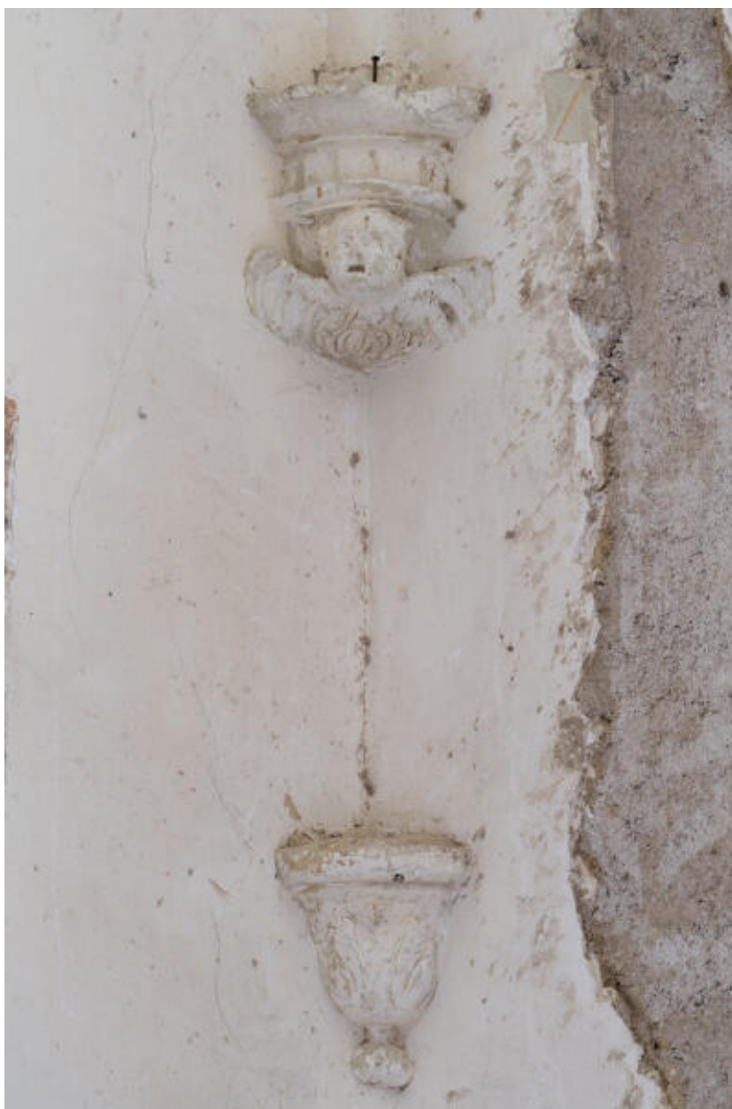
Chapelle latérale : retombée de voûte.
