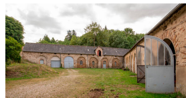
Les dépendances près du moulin. Phot. Pierre-Bernard Fourny IVR52_20235301073NUCA
