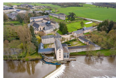
Une vue aérienne de l'abbaye. Phot. Pierre-Bernard Fourny IVR52_20235300173NUCA
