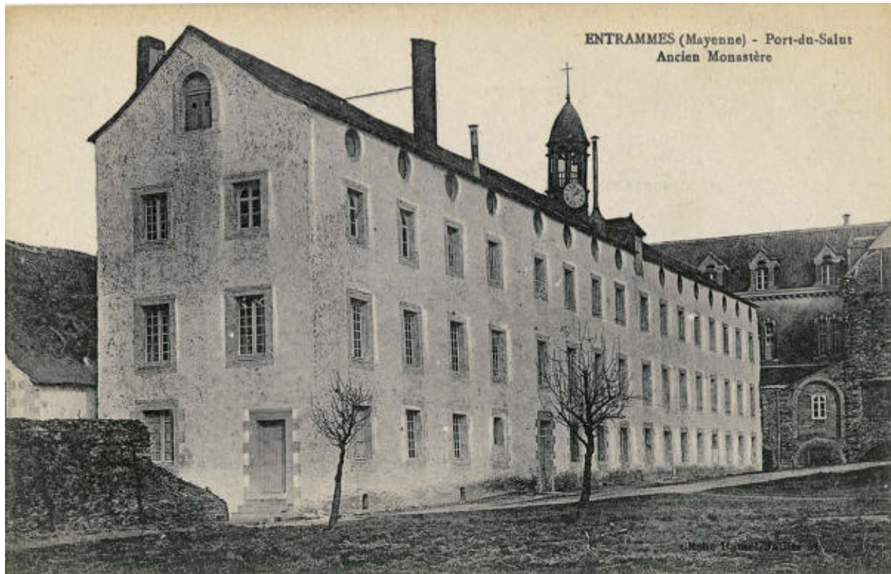
Le bâtiment conventuel dit ancien monastère, carte postale du XXe siècle.
