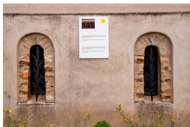
Les baies romanes du prieuré primitif. Phot. Pierre-Bernard Fourny IVR52_20235301071NUCA
