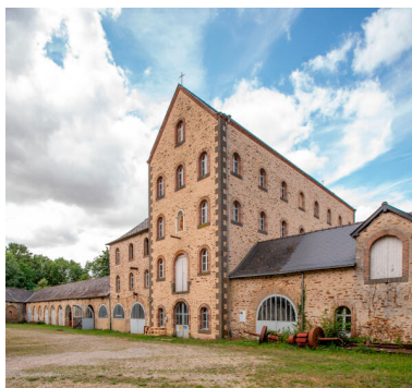
Le moulin. Phot. Pierre-Bernard Fourny IVR52_20235301072NUCA
