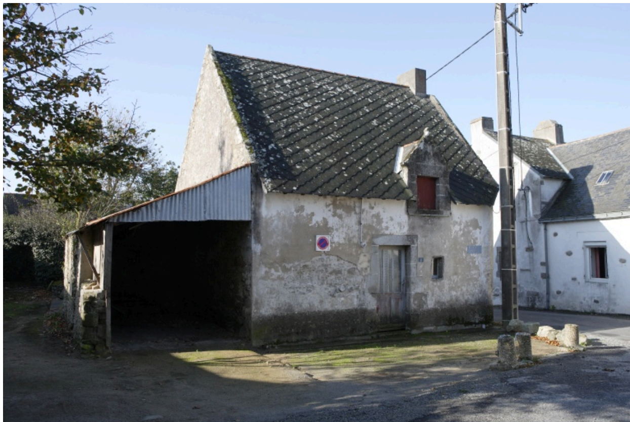
Vue du logis depuis l'est.
