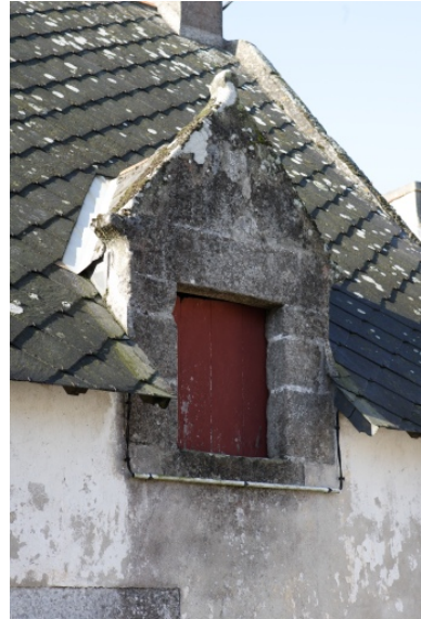
Détail de la lucarne de la façade principale. Phot. Denis Pillet IVR52_20074401287NUCA
