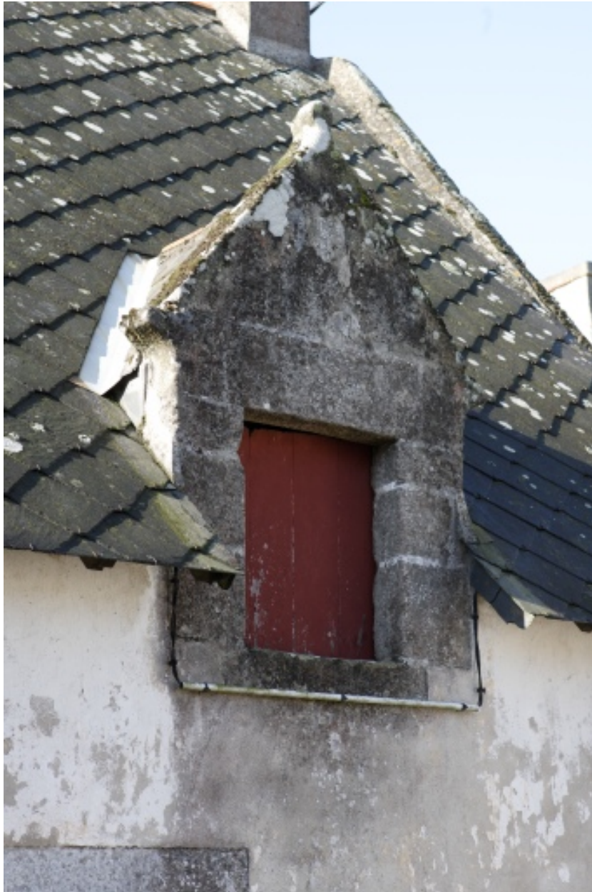
Détail de la lucarne de la façade principale.
