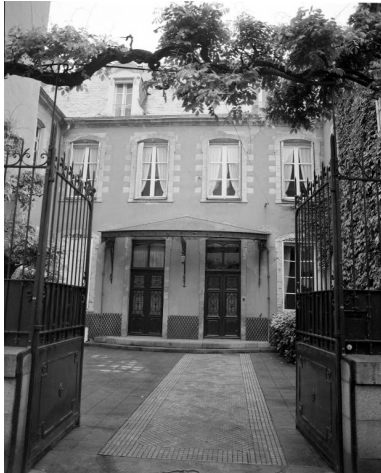
Elévation antérieure sur cour. Phot. Jacques Le Callonnec IVR52_19775300698X
