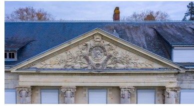
Élévation postérieure. Détail du fronton. Phot. Pierre-Bernard Fourny IVR52_20214401067NUCA
