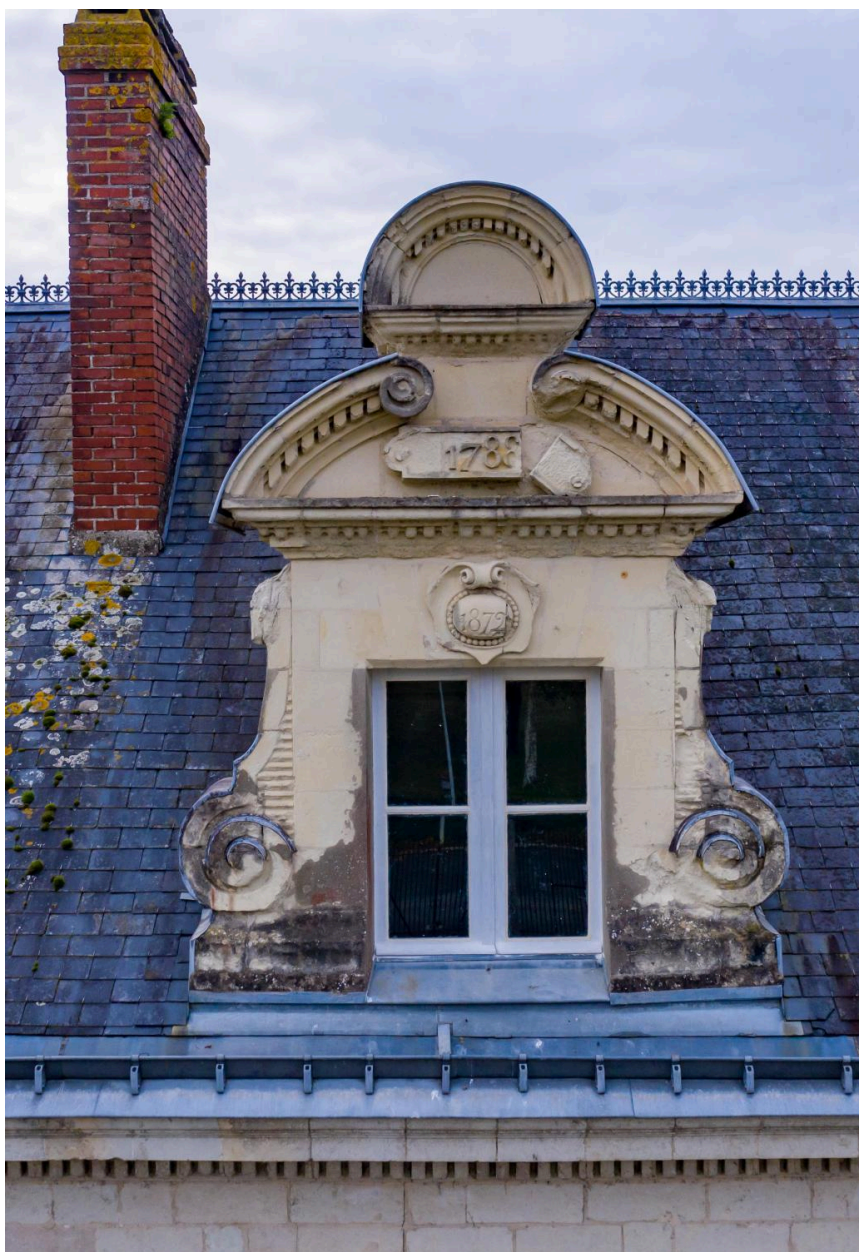
Élévation est. Détail de la lucarne axiale.
