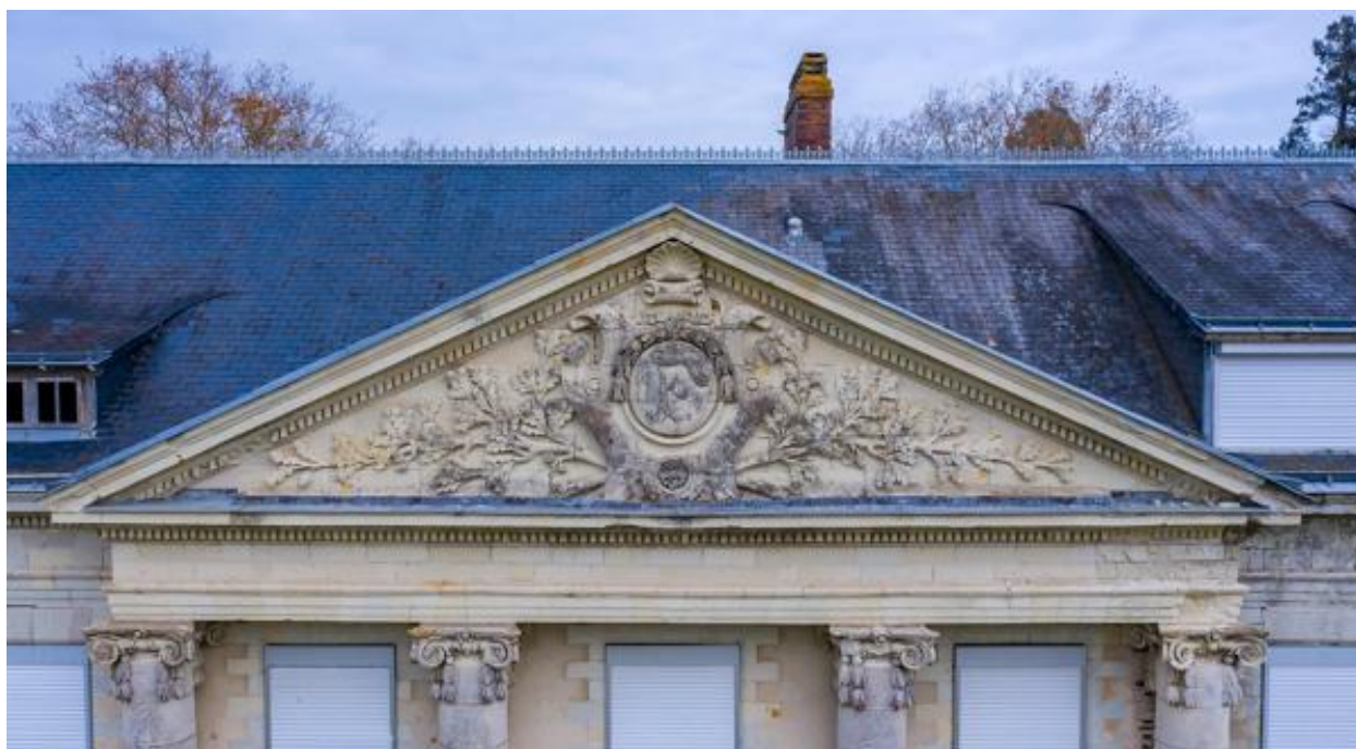
Élévation postérieure. Détail du fronton.
