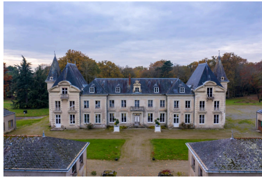
Élévation antérieure du logis. Phot. Pierre-Bernard Fourny IVR52_20214401083NUCA
