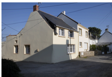
Vue d'ensemble depuis le nord-ouest. Phot. Denis Pillet IVR52_20084400344NUCA
