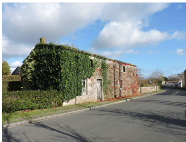
L'ancienne maison vue depuis l'ouest. Phot. Yannis Suire IVR52_20218500853NUCA
