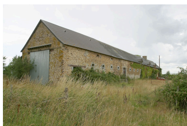
Vue d'ensemble depuis le sud-est. Phot. François Lasa IVR52_20035302203NUCA
