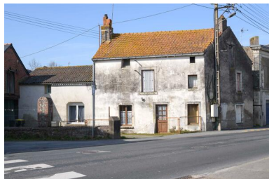
Elévation principale. Phot. Armelle Maugin IVR52_20254900238NUCA
