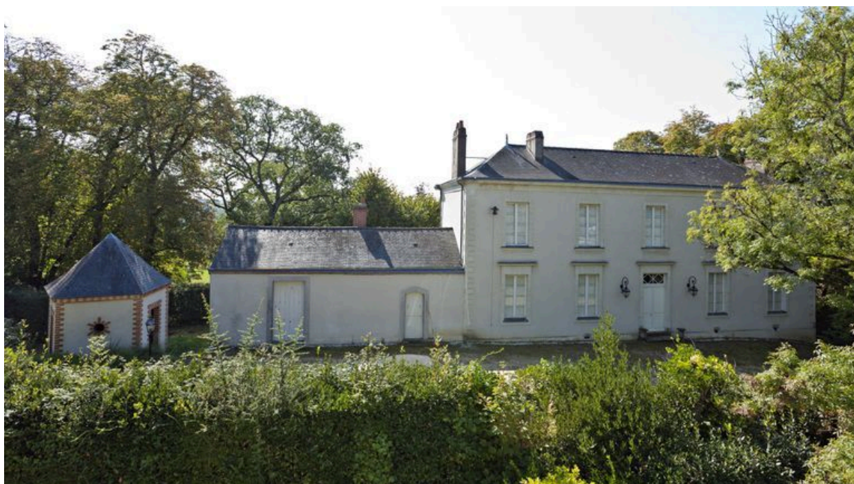
La maison de maître : élévations nord.
