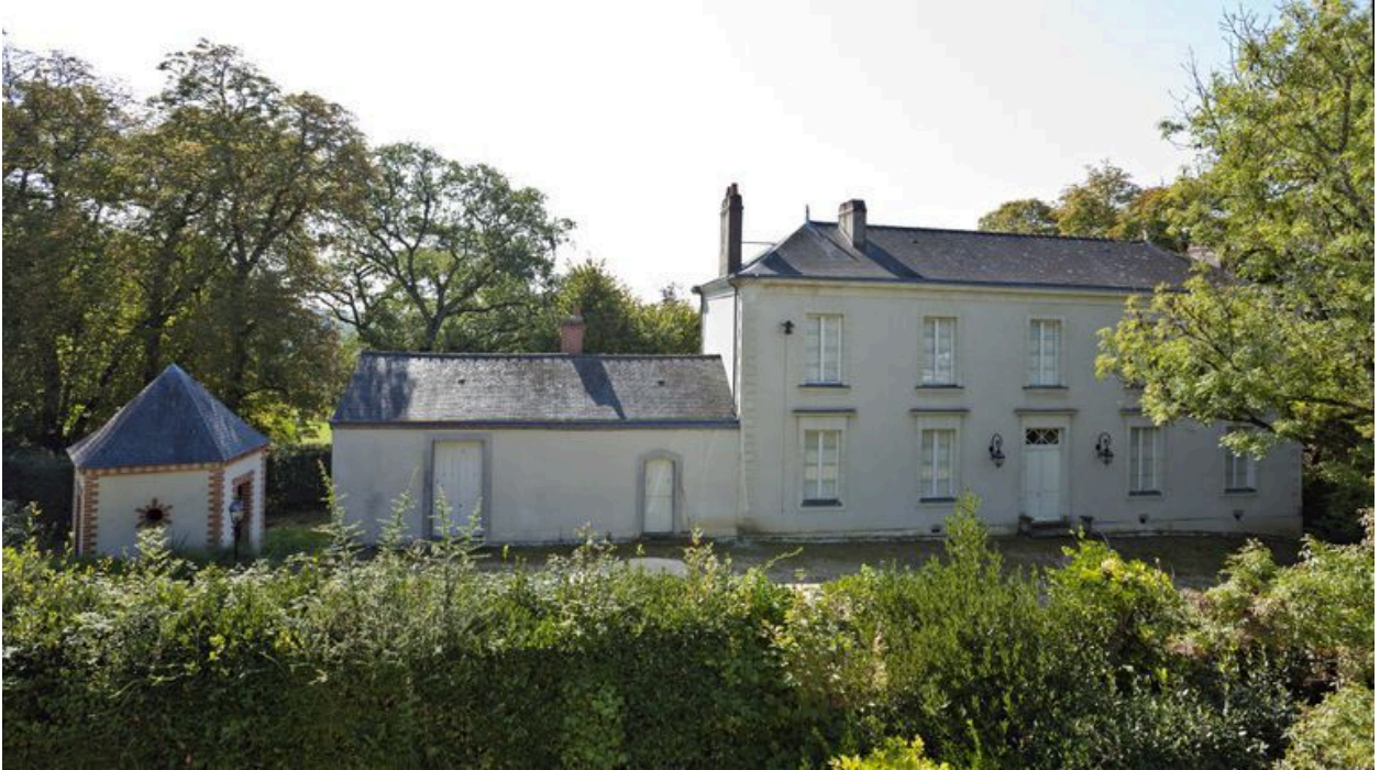
La maison de maître : élévations nord.
