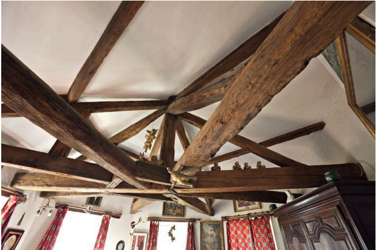
La dépendance sud, aile pentagonale : détail de la charpente.
