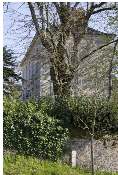
La maison de maître, vue du coteau. Phot. Yves Guillotin IVR52_20114400168NUCA
