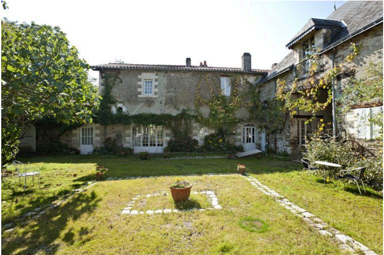
La dépendance sud : élévations nord, sur cour.
