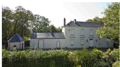
La maison de maître : élévations nord. Phot. Yves Guillotin IVR52_20114400786NUCA
