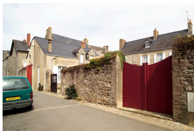
Vue générale depuis la rue du Tricot. Phot. Denis Pillet IVR52_20074400438NUCA
