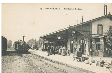
Vue de la gare dans la 1ère moitié du XXe siècle. A noter l'avant-toit porté par des aisseliers régnant sur l'ensemble du bâtiment.
