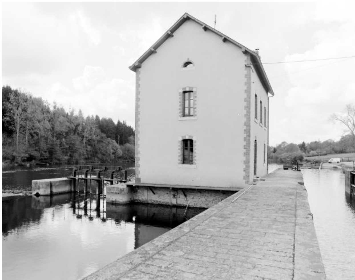
La façade nord-est, en amont. A gauche, le pertuis. A droite, l'écluse.
