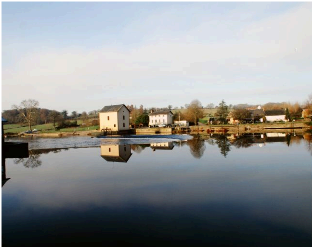
Vue d'ensemble du site du moulin depuis la rive gauche, en amont : barrage, pertuis, moulin, maison éclusière. A droite, les anciennes dépendances, transformées en gîte et en restaurant.
