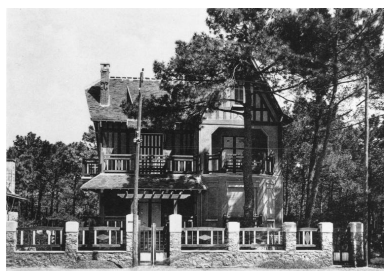
Façade sud de la villa anglo-normande de la Glorita de M. Gauthier.
