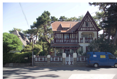
Vue d'ensemble de la villa La Glorita. Phot. Denis Pillet IVR52_20044401281NUCA
