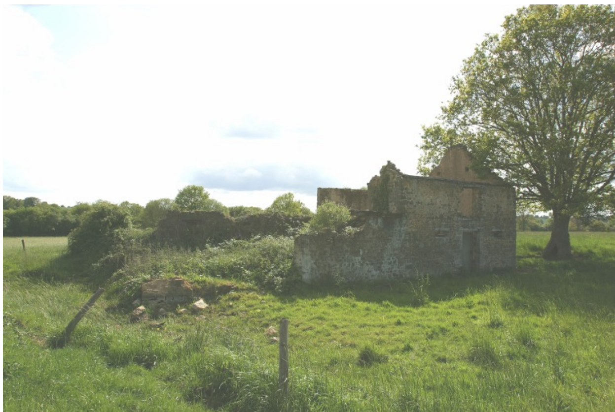
L'étable-grange vue depuis l'est.
