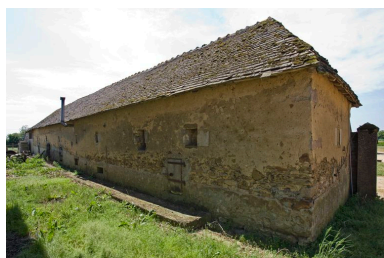
Porcherie, élévation est. Phot. Yves Guillotin IVR52_20117200606NUCA
