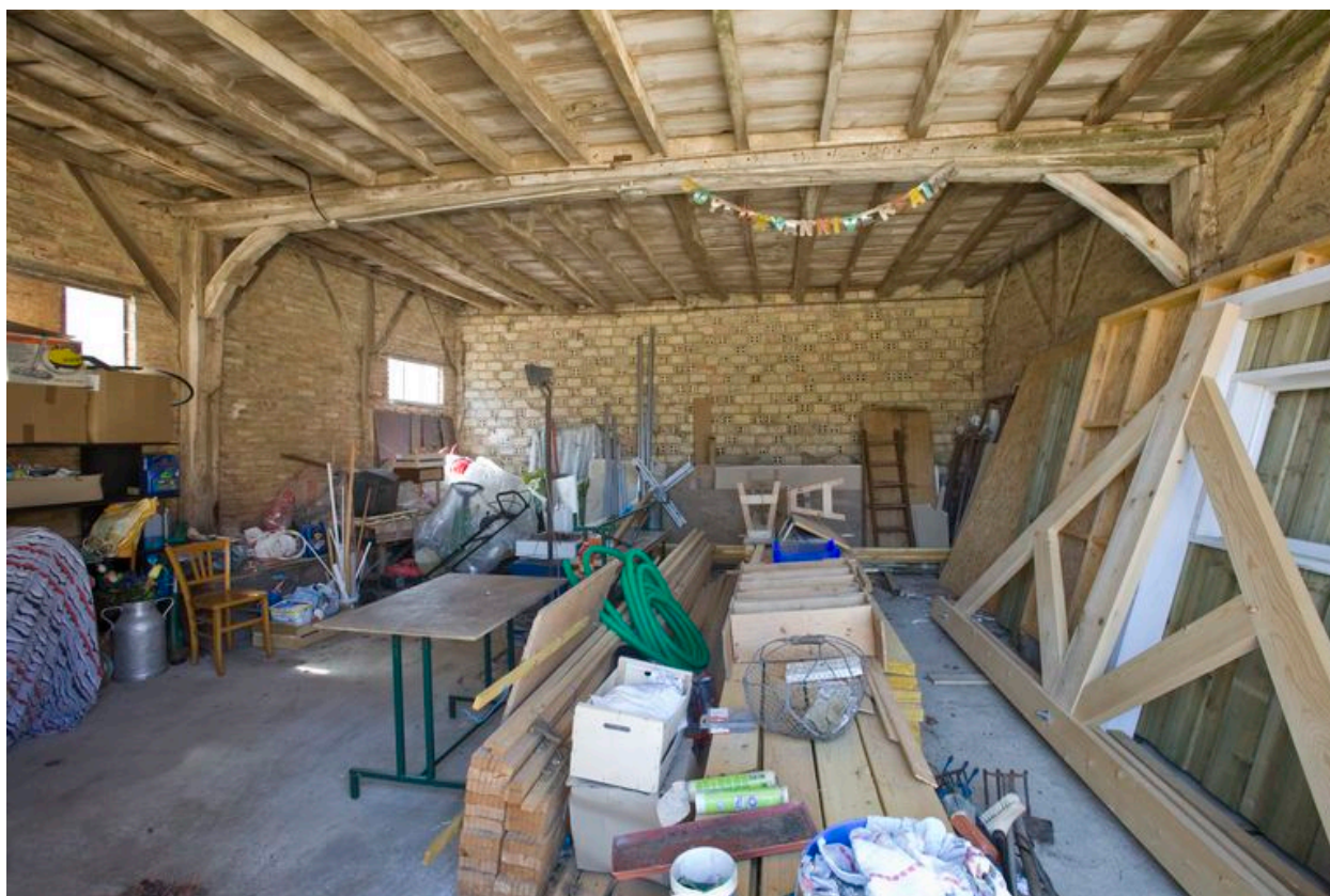
Remise : vue intérieure.
