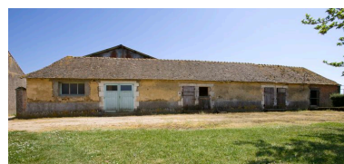
Porcherie : élévation ouest. Phot. Yves Guillotin IVR52_20117200602NUCA
