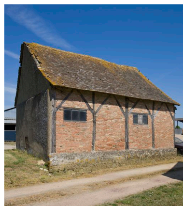
Remise, élévation sud. Phot. Yves Guillotin IVR52_20117200604NUCA
