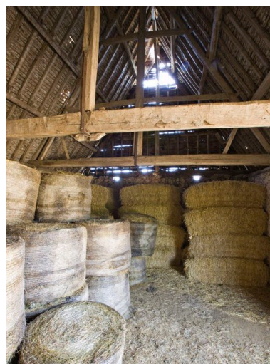
Vue intérieure de la grange-étable. Phot. Yves Guillotin IVR52_20117200666NUCA
