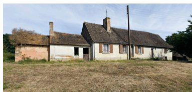
Elévations antérieure du logis et du fournil. Phot. Yves Guillotin IVR52_20117200663NUCA
