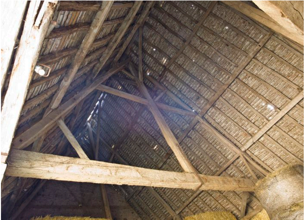
Ferme de charpente gauche de la grange-étable.
