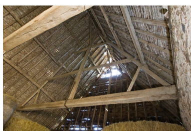
Ferme de charpente droite de la grange-étable. Phot. Yves Guillotin IVR52_20117200665NUCA
