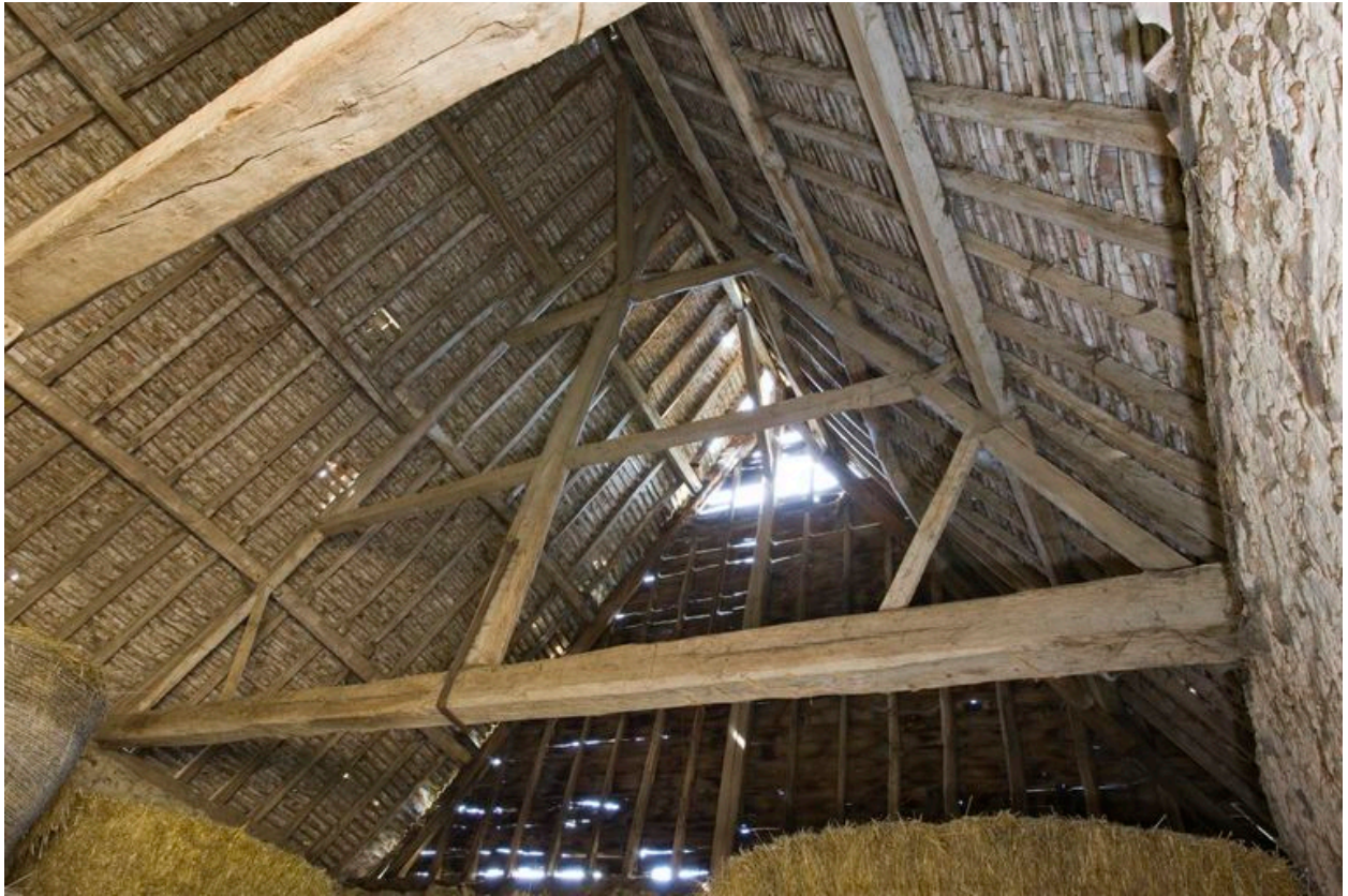
Ferme de charpente droite de la grange-étable.
