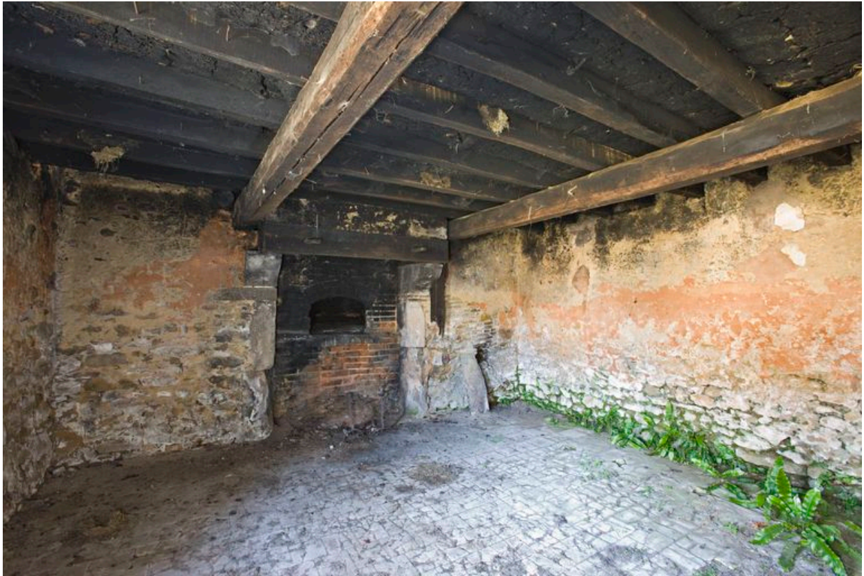
Vue intérieure du fournil.
