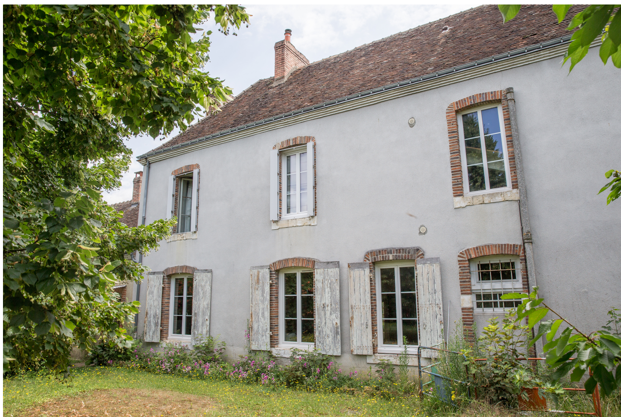
La façade postérieure.
