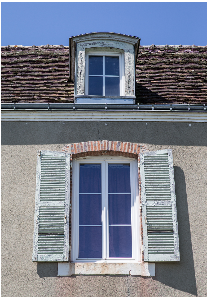
Un détail d'une fenêtre et d'une lucarne.
