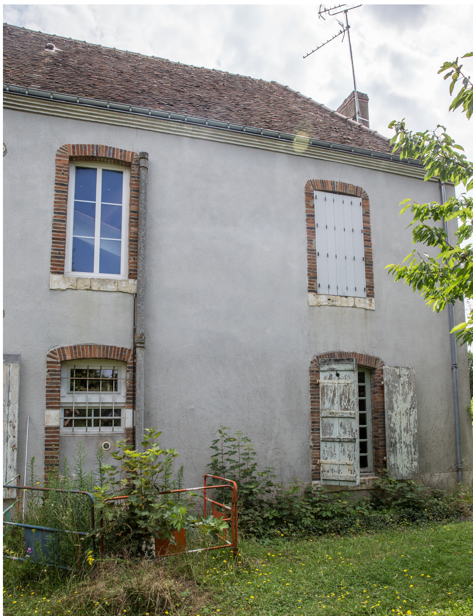
La façade postérieure.
