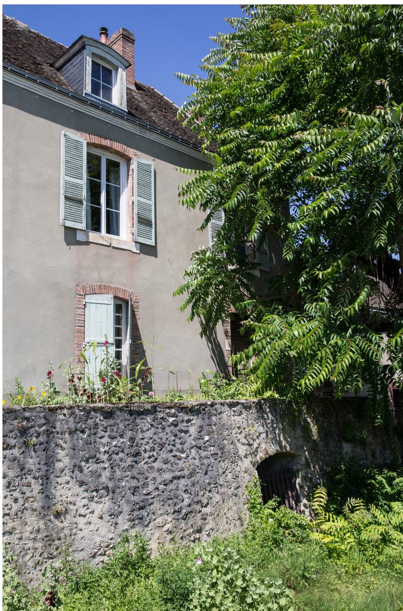
Un détail d'une travée et l'entrée des caves.
