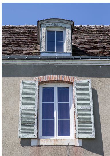
Un détail d'une fenêtre et d'une lucarne. Phot. Pierre-Bernard Fourny IVR52_20187201090NUCA
