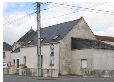
Détail des pignons découverts du 4 place de l'Eglise. Phot. Armelle Maugin IVR52_20254900638NUCA
