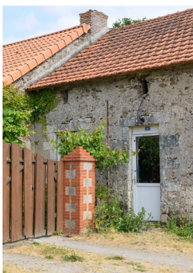
Détail d'ouvertures en pierre de taille de tuffeau (RDC) et moellons de schiste (CS) d'un des logis du Plessis Pasquier. Phot. Armelle Maugin IVR52_20254900649NUCA
