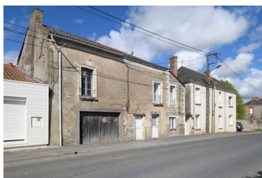
Vue d'ensemble du 3, 5, 7 rue de la Loire. Phot. Armelle Maugin
