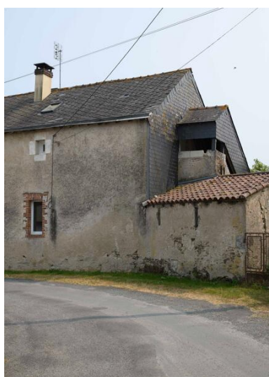
Détail de l'escalier couvert du 2 rue de la Promenade. Phot. Armelle Maugin IVR52_20254900688NUCA
