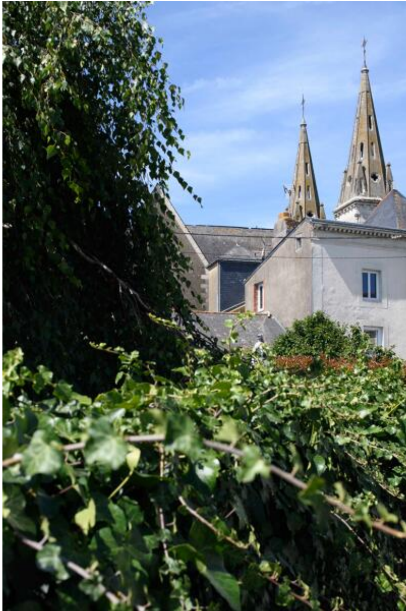
Vue de la tour de distribution du 6-7 place de l'Eglise.
