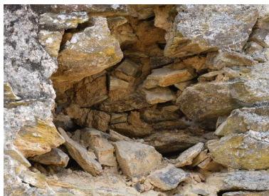
Détail de la composition du pignon nord de l'étable de la Petite Touche Fleury (moellons de schiste avec mortier de terre). Phot. Armelle Maugin IVR52_20254900667NUCA
