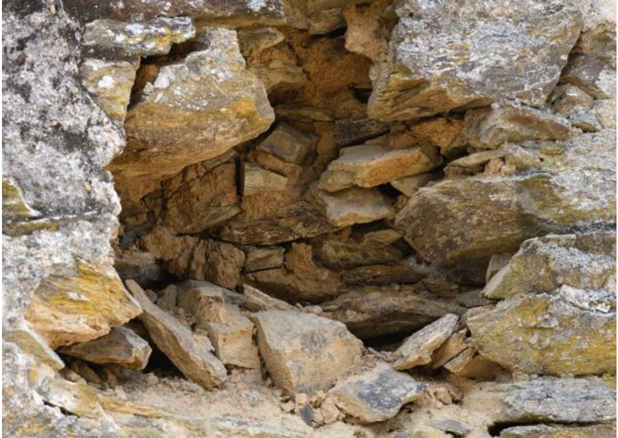
Détail de la composition du pignon nord de l'étable de la Petite Touche Fleury (moellons de schiste avec mortier de terre).
