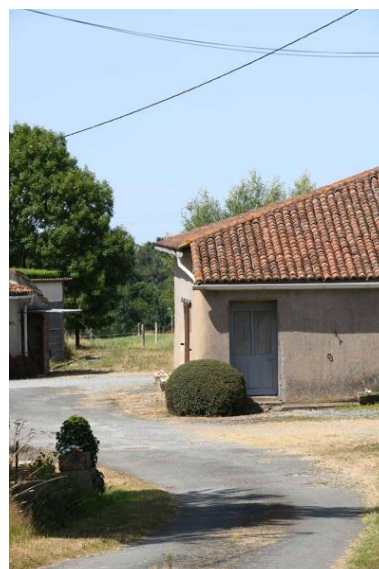
Détail de l'angle arrondi de l'étable des Petites Marottières. Phot. Armelle Maugin IVR52_20254900931NUCA
