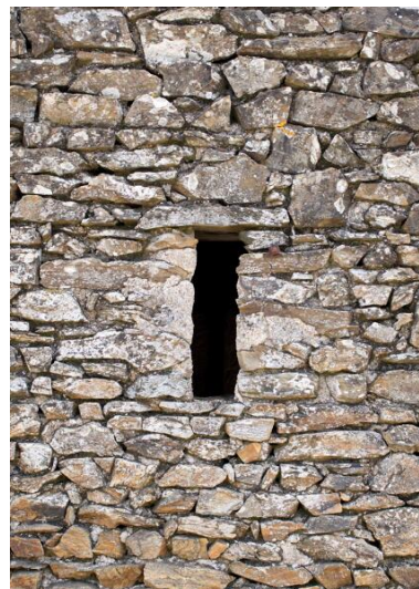
Détail d'une ouverture en moellons de schiste du mur ouest de l'étable, Touche Fleury. Phot. Armelle Maugin IVR52_20254900659NUCA
