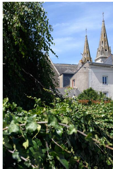
Vue de la tour de distribution du 6-7 place de l'Eglise. Phot. Armelle Maugin IVR52_20254900910NUCA
