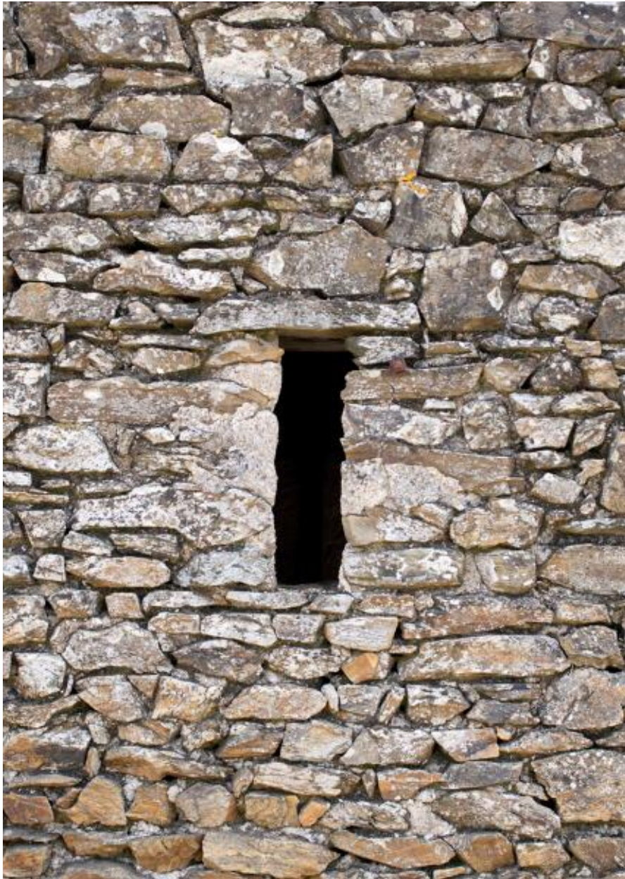
Détail d'une ouverture en moellons de schiste du mur ouest de l'étable, Touche Fleury.
