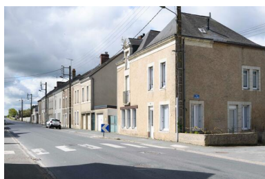
Vue d'ensemble de la rue de Vendée depuis le nord. Phot. Armelle Maugin IVR52_20254900632NUCA
