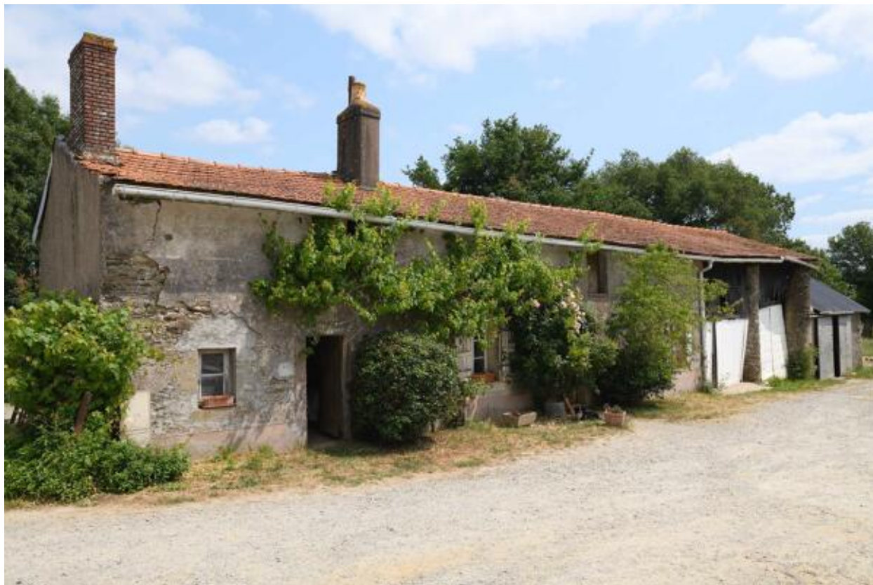
Vue d'ensemble de la façade sud du logis de la Petite Touche Fleury.
