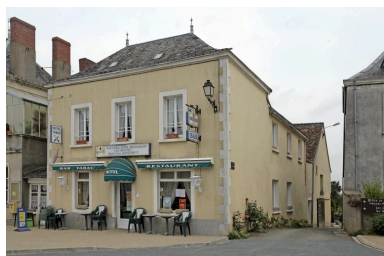
Vue depuis la rue au nord. Phot. François Lasa IVR52_20075302170NUCA
