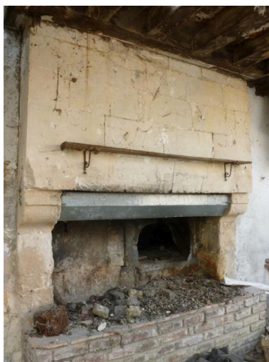
Maison, pièce à feu ouest : cheminée au mur-pignon. Phot. Stéphanie Aquilon IVR52_20127200711NUCA
