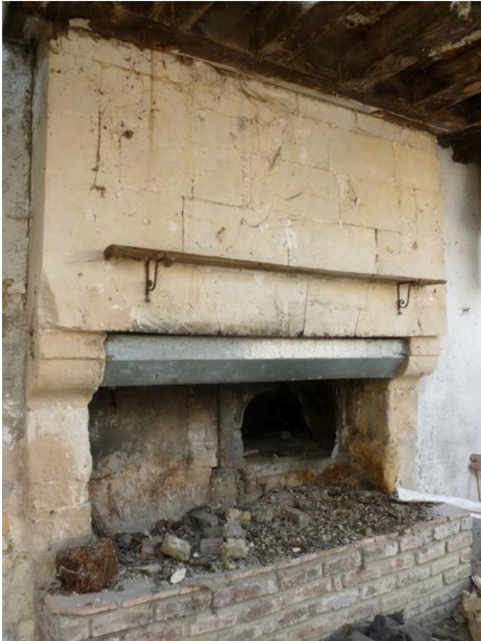
Maison, pièce à feu ouest : cheminée au mur-pignon.
