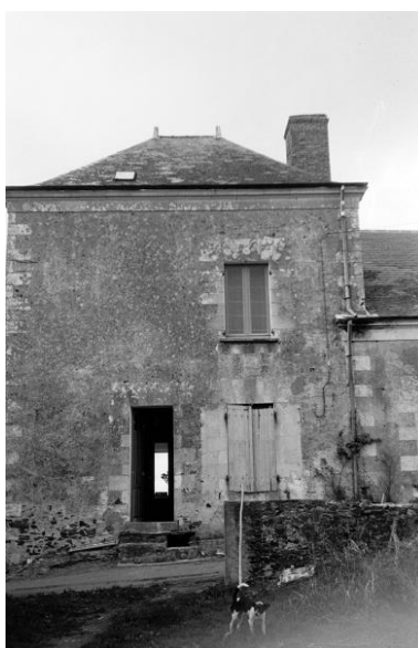
Logis en pavillon, 1972. Phot. Marie-Anne Eon IVR52_19724900380Z
