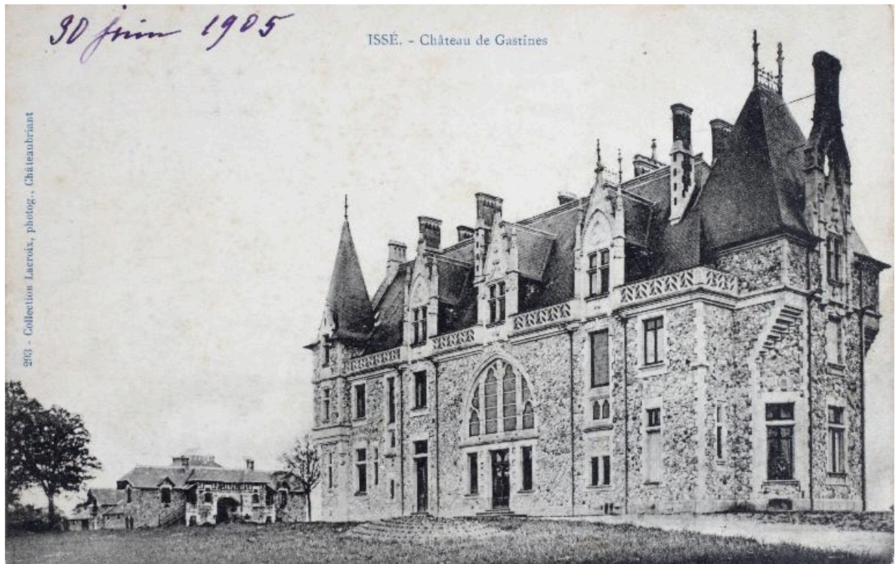
Façade nord avec en arrière plan les haras, 1905.
