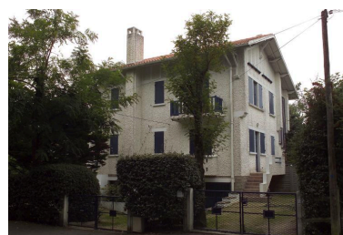
Vue de l'angle nord-ouest de la villa Ohentzea. Phot. Denis Pillet IVR52_20044402692NUCA
