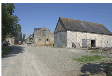
La petite étable vue depuis le sud-est. Au fond les dépendances de l'ancien manoir. Phot. François Lasa IVR52_20045301846NUCA
