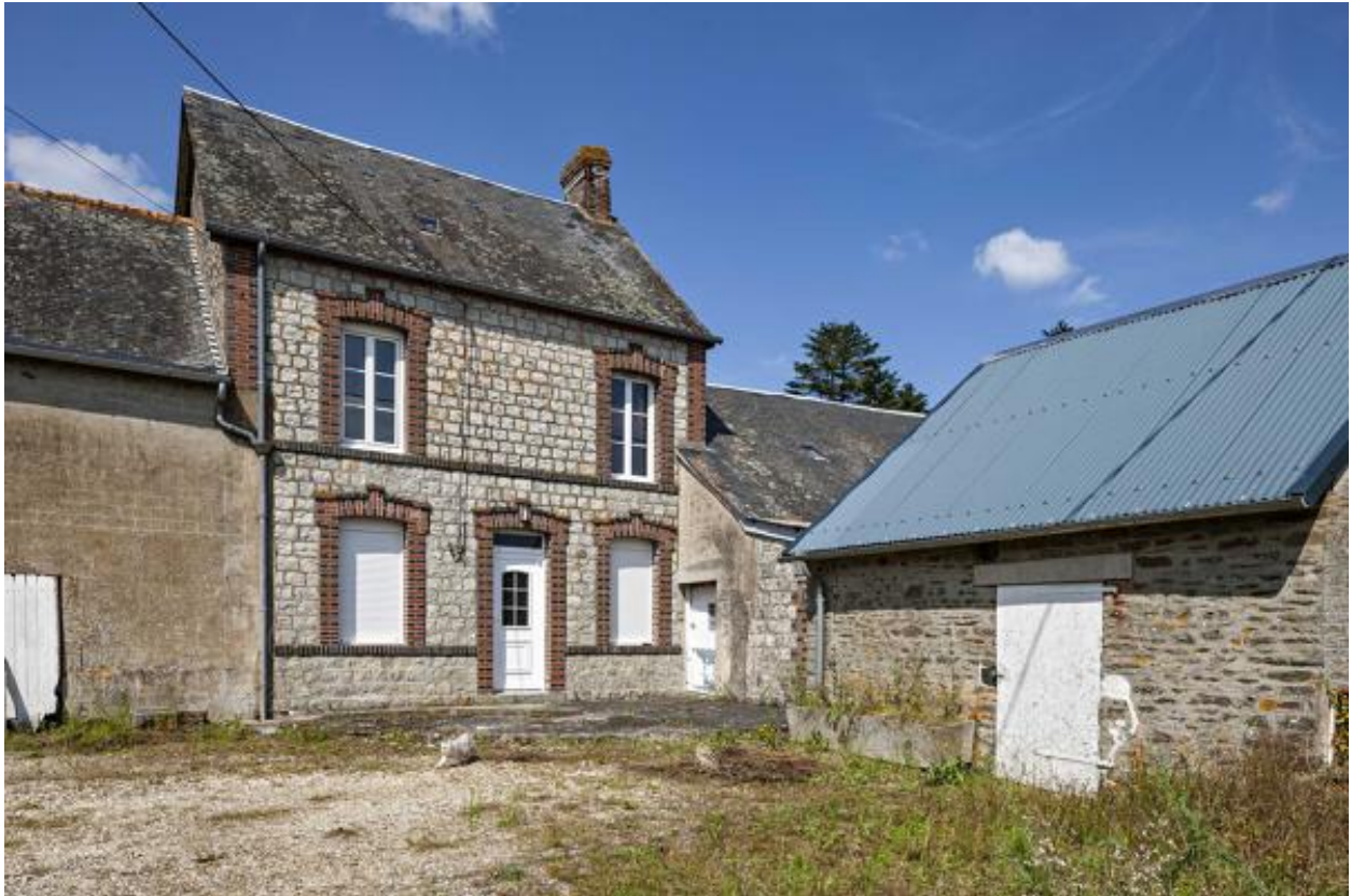
Alignement nord-est (2023 ZE 187), maison reconstruite vers 1890.
