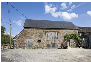
Etable, grange, porcherie en appentis (2023 ZD 148). Phot. Yves Guillotin IVR52_20215300911NUCA
