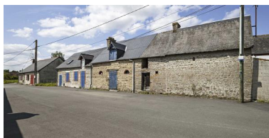
Alignement nord, central (2023 ZE 50-51). Phot. Yves Guillotin IVR52_20215300910NUCA
