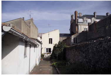
Vue d'ensemble depuis la cour. Phot. Denis Pillet IVR52_20034401635NUCA
