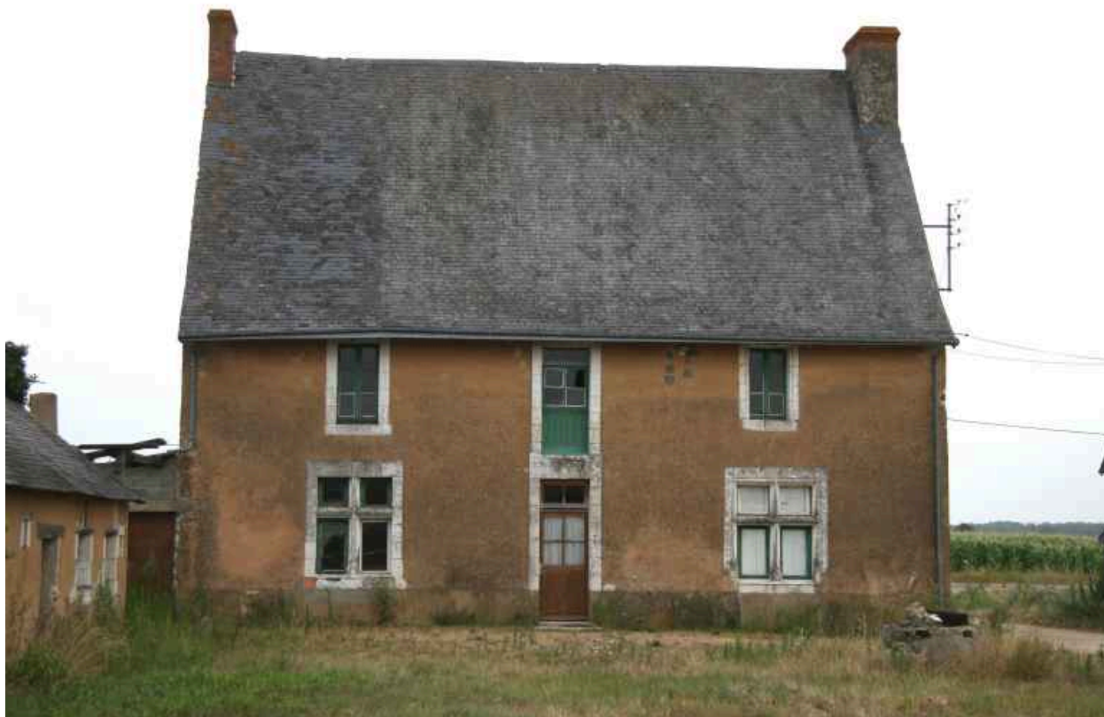
Façade antérieure sur cour.
