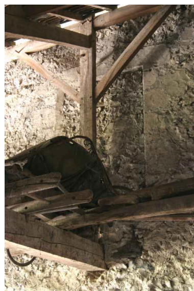
Façade postérieure : baie à l'étage. Phot. Jean-Baptiste Darrasse IVR52_20067206399NUCA
