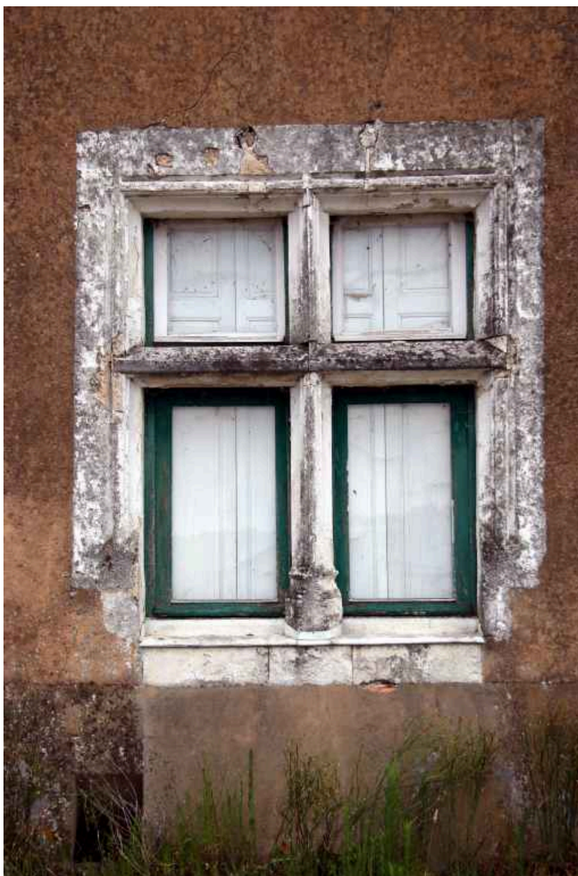
Croisée droite au rez-de-chaussée.
