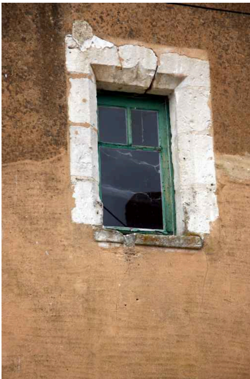
Baie chanfreinée dans le pignon.
