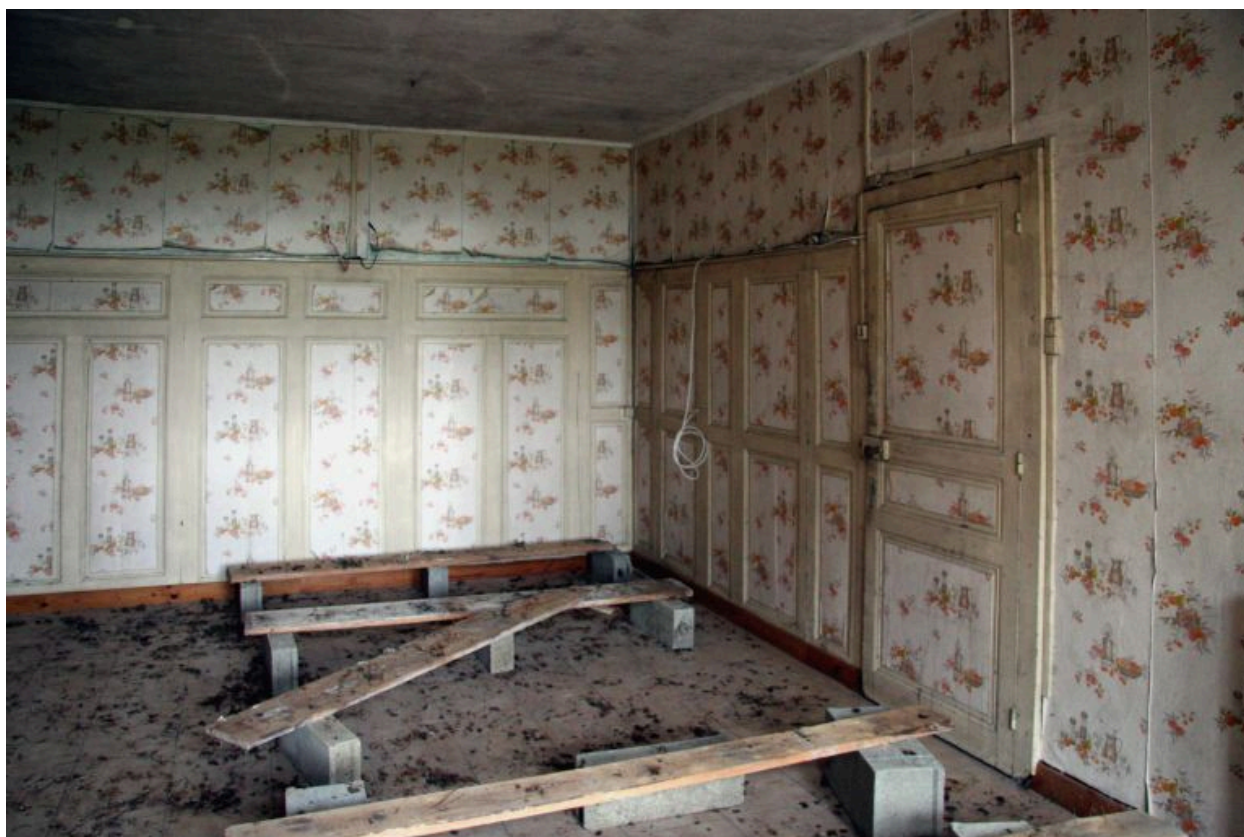
Rez-de-chaussée, salle à gauche : lambris de récupération.
