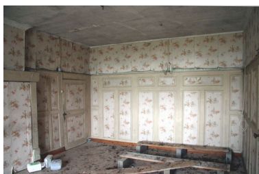
Rez-de-chaussée, salle de gauche : lambris XIXe siècle. Phot. François Lasa IVR52_20077200802NUCA
