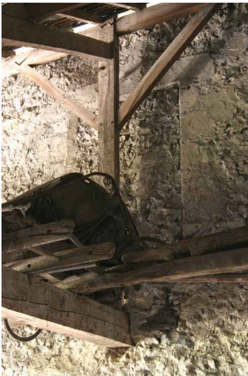
Façade postérieure : baie à l'étage.
