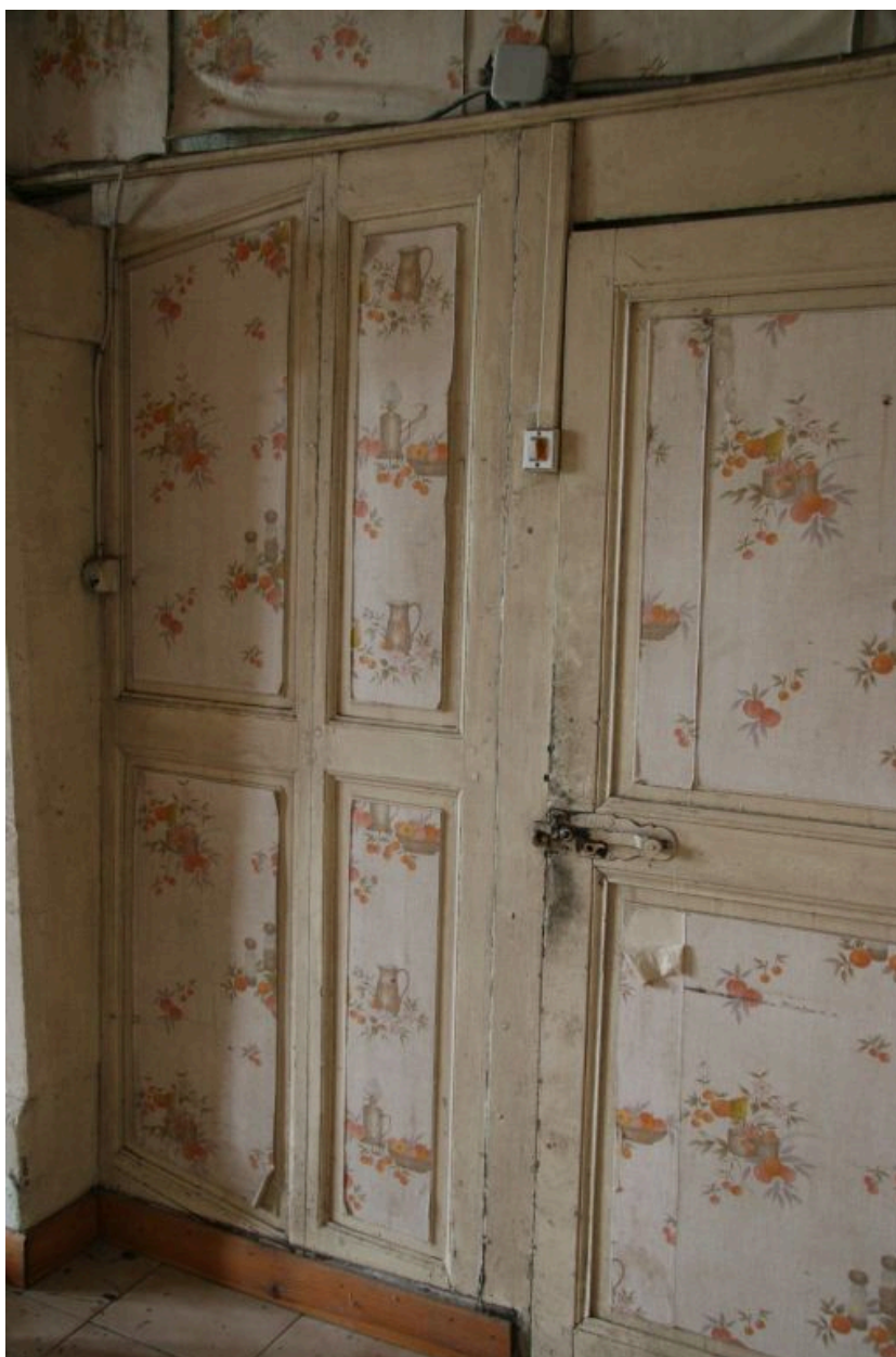
Rez-de-chaussée, salle à gauche : lambris XIXe siècle de récupération.
