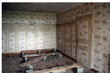
Rez-de-chaussée, salle à gauche : lambris de récupération. Phot. Jean-Baptiste Darrasse IVR52_20077200803NUCA
