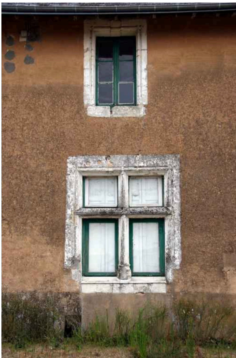
Travée de baies à droite : croisée et demie baie.
