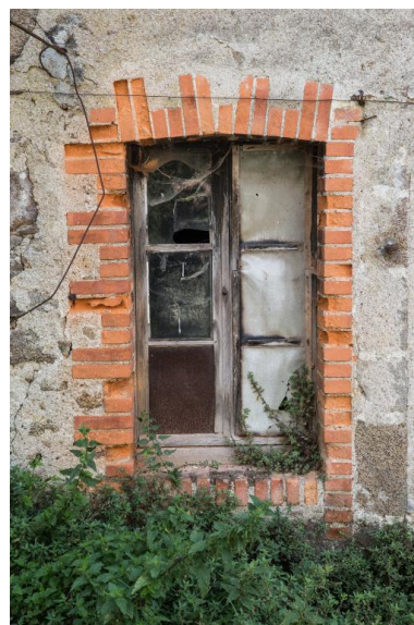
Habitation avec étage de stockage en surcroît. Détail de la baie avec encadrement en briques. Rousselin, Boussay, cadastre 2018, 000 ZW 01-126. Phot. Pierre-Bernard Fourny IVR52_20184400264NUCA
