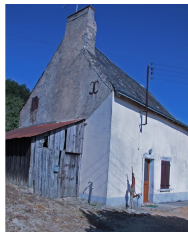
Vue de volume. Phot. Jean-Baptiste Darrasse IVR52_20097200571NUCA
