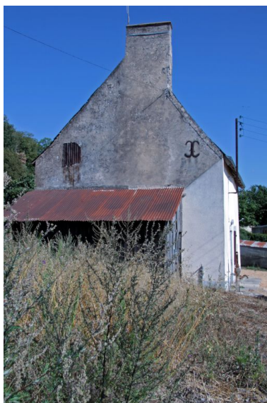
Pignon nord partiellement engagé dans le coteau. Phot. Jean-Baptiste Darrasse IVR52_20097200569NUCA
