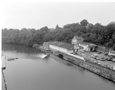
Vue d'ensemble du site du moulin détruit, depuis le viaduc. Phot. François Lasa IVR52_20025301207X
