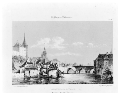
Vue d'aval des Grands Moulins de Mayenne avant leur reconstruction. Autr. Jean-Baptiste Messenger, Phot. François (reproduction) Lasa IVR52_20025300020X
