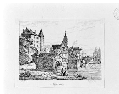
Vue d'aval des Grands Moulins de Mayenne avant leur reconstruction. Autr. Fleury, Autr. Boullemier, Phot. François (reproduction) Lasa IVR52_20025300037X
